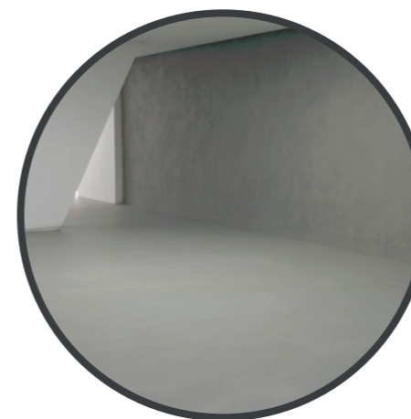
LITÁ EPOXIDOVÁ PODLAHA
