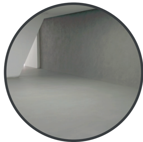
LITÁ EPOXIDOVÁ PODLAHA
