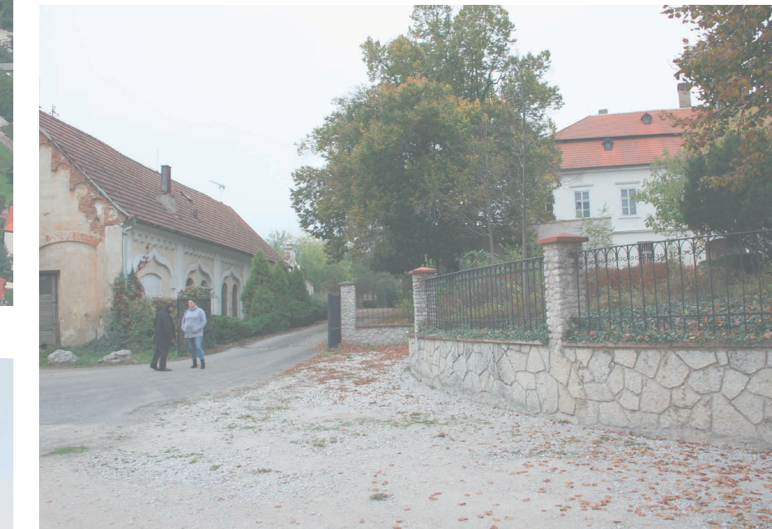
Pohled z nádvoří na ulici Zámecká
