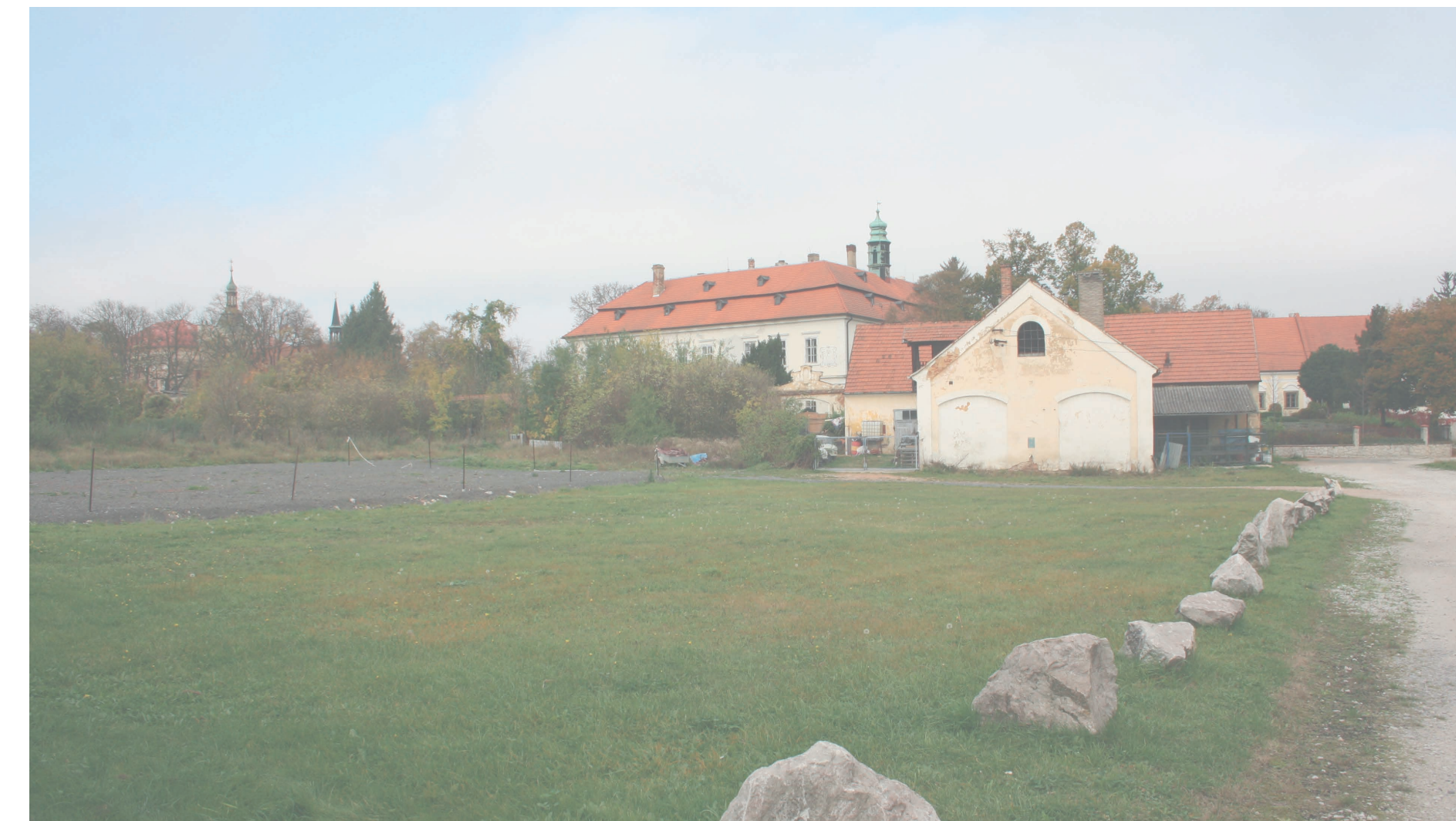
Pohled od ulice Nádražní na zámecký areál
