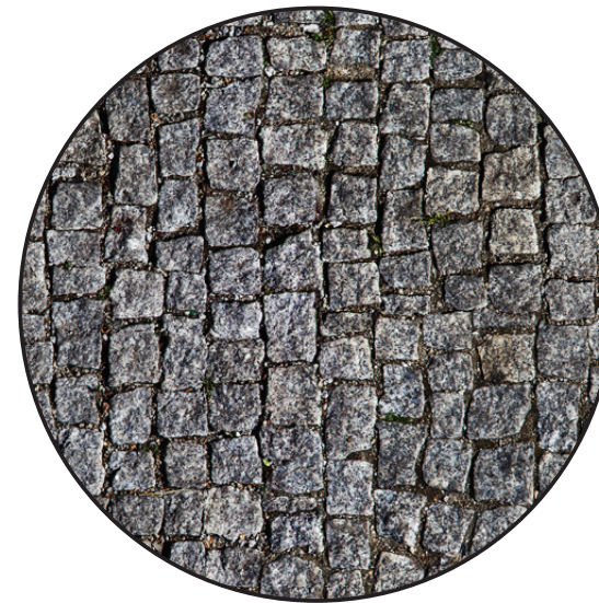
dlažba - žulové kostky
