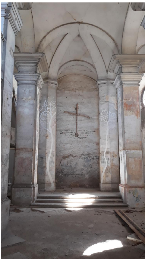
Obrázek 33: Pohled od vchodu uvnitř kostela
