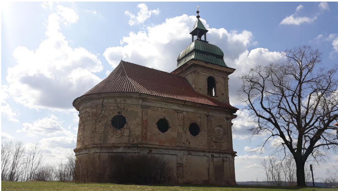
Obrázek 31: Severovýchodní pohled na kostel
