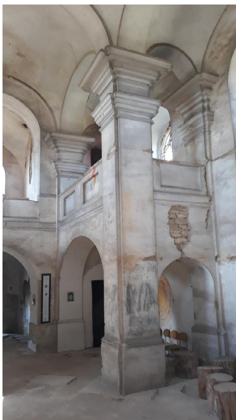
Obrázek 34: Pohled na pravý balkon od presbytáře
