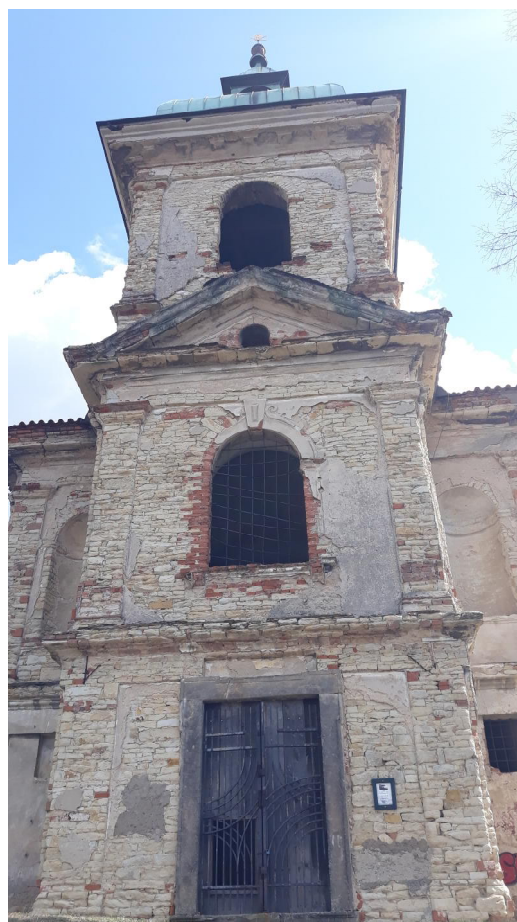
Obrázek 32: Pohled na kostel z průčelí
