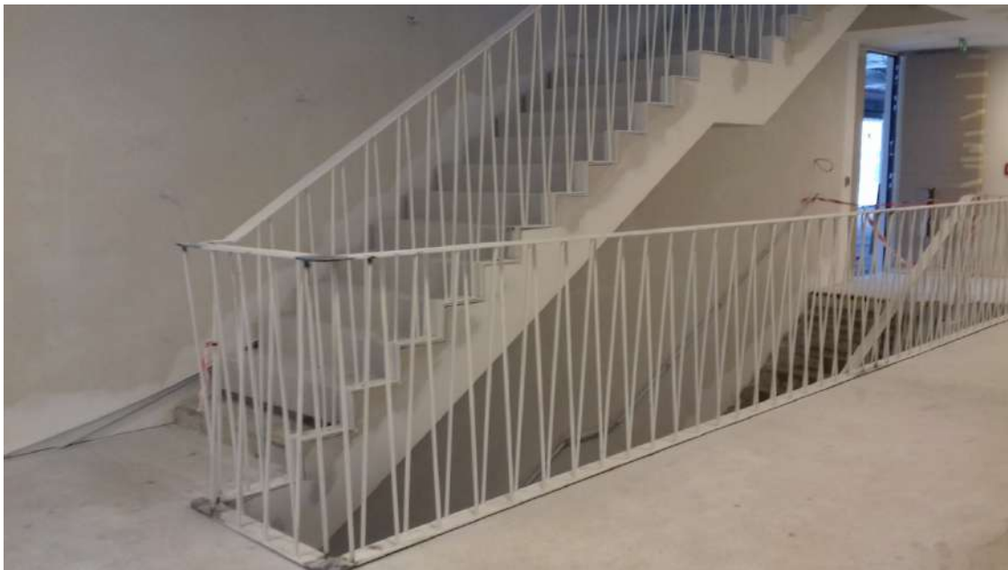
Obrázek 12: Hlavní schodiště ve výtahovém jádře (zdroj: vlastní fotodokumentace)
