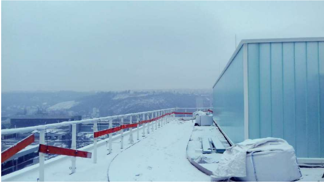
Obrázek 18: Akustická stěna na střeše objektu A1 a příprava pro položení povrchu běžeckého okruhu (zdroj: vlastní fotodokumentace)
