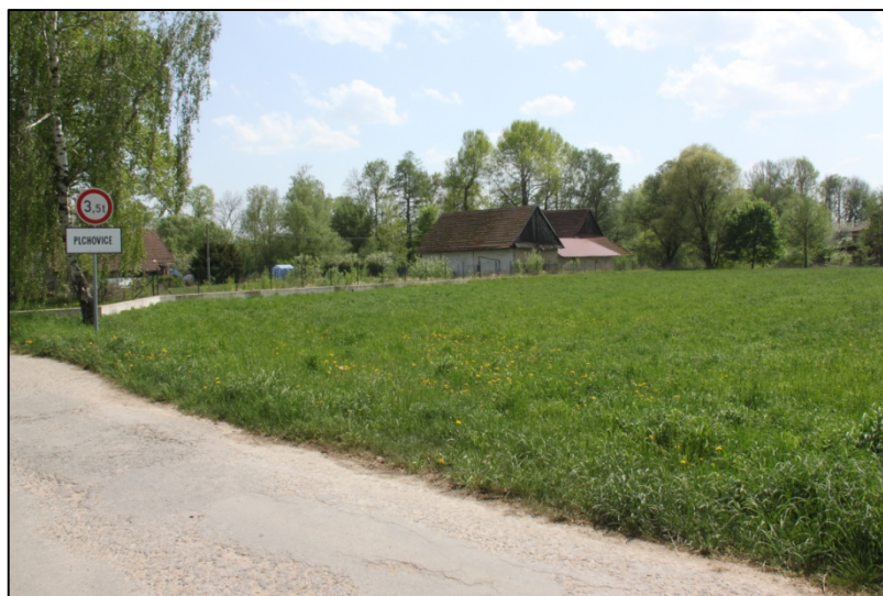
Fot. 13 Pohled na protipovodňovou bariéru v místě kde dříve byl rybník Malý
