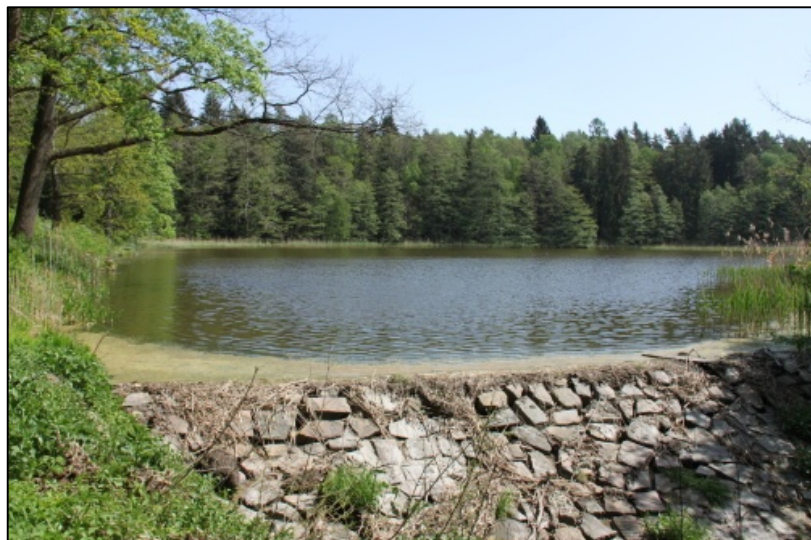
Fot. 16 Pohled na bezpečnostní přeliv rybníku Dolní Pecák
