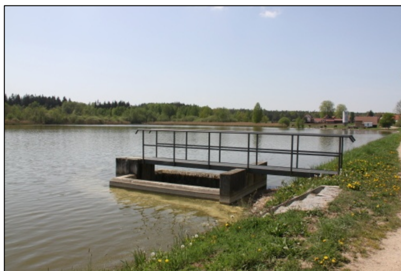
Fot. 6 Pohled na bezpečnostní přeliv rybníku Malý Karlov
