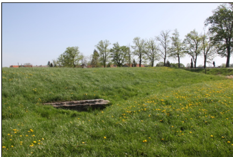
Fot.1 Pohled na hráz rybníka zvaného Za kostelni
