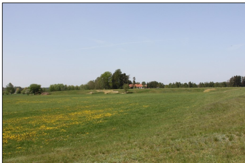
Fot. 12 Pohled na hráz rybníku Welky ze dříve zatopené strany
