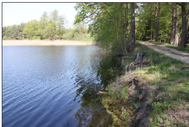
Fot. 3 Pohled na hráz stávajícího rybníku Hanzlíkovec
