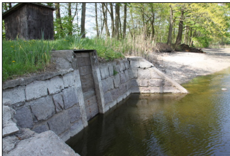
Fot. 14 Stavidlo rybníku Mnichovec
