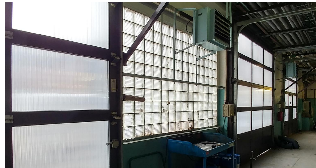
Severní průčelí vozovny, pohled z interiéru
