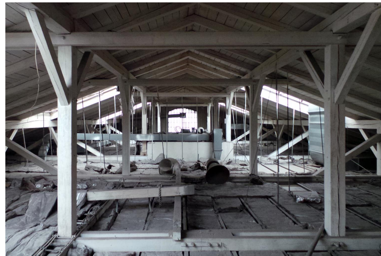
pohled do krovu nad podhledem
