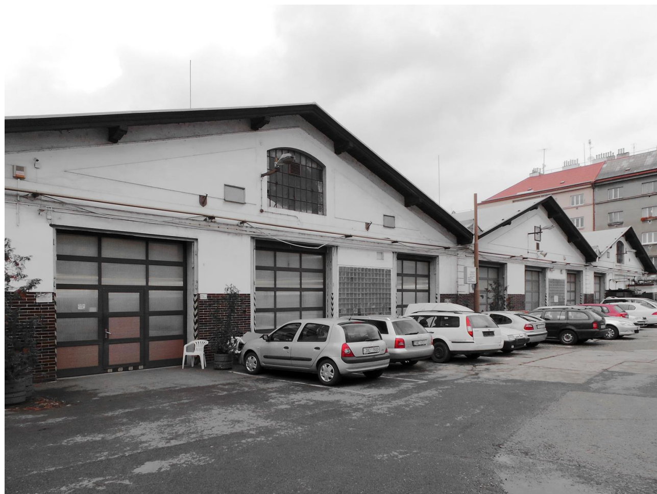
Současný stav severní fasády
