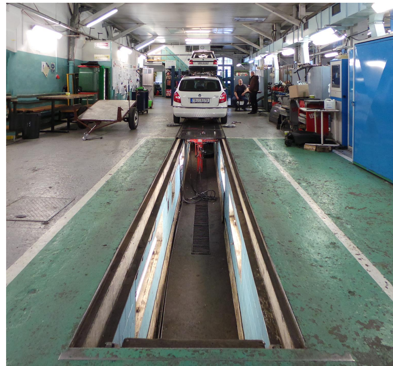
Povrch stávající stěrkové podlahy a montážní jáma
