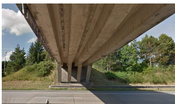
Obrázek 42: Bližší pohled na nadjezd na dálnici D1 km 120. [19]
