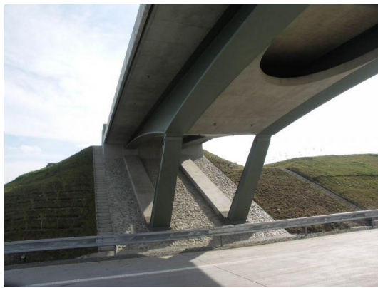
Obrázek 19: Ocelobetonový vzpěradlový most přes dálnici D1. [14]
