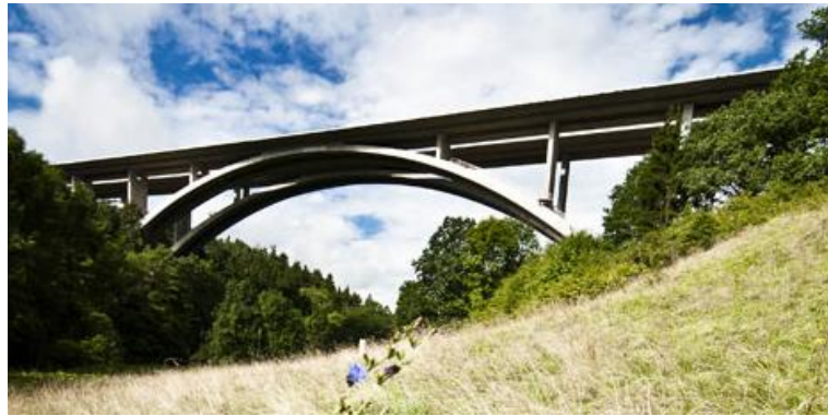
Obrázek 15: Betonový obloukový most s horní mostovkou přes Oparenské údolí.[10]
