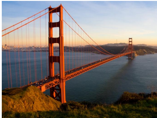
Obrázek 21: Ocelový visutý most Golden Gate San Francisco. [16]
