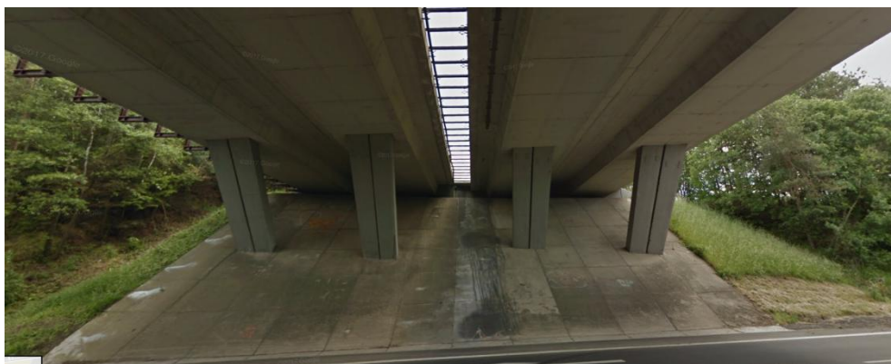
Obrázek 48: Bližší pohled na nadjezd na dálnici D1 km 90. [19]
