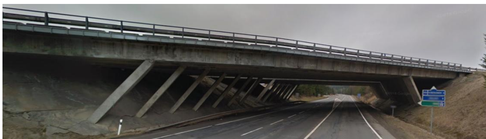
Obrázek 43: Most převádějící dálnici D1 km 119. [19]
