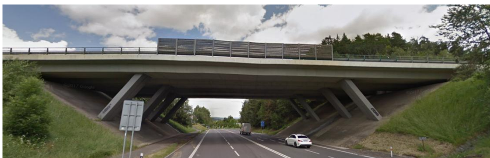
Obrázek 47: Most převádějící dálnici D1 km 90. [19]
