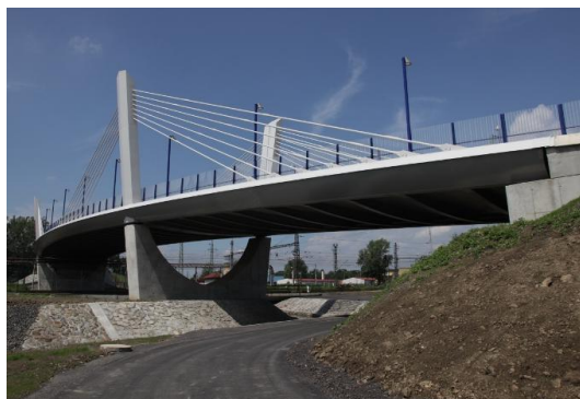
Obrázek 20: Ocelový zavěšený most se spřaženou železobetonovou deskou přes železniční trať, Bohumín. [15]
