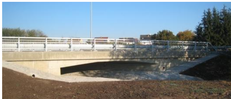
Obrázek 14: Rámový silniční most v obci Zbůch.[9]
