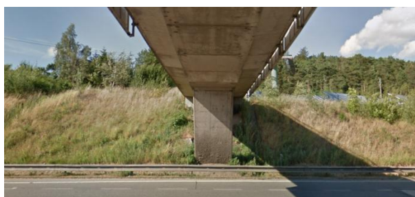
Obrázek 40: Bližší pohled na nadjezd na dálnici D1 km 145. [19]
