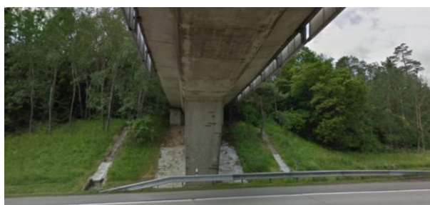
Obrázek 36: Bližší pohled na nadjezd na dálnici D1 km 175. [19]
