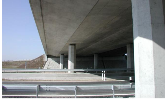
Obrázek 12: Nosná konstrukce tvořena lichoběžníkovou deskou.[7]
