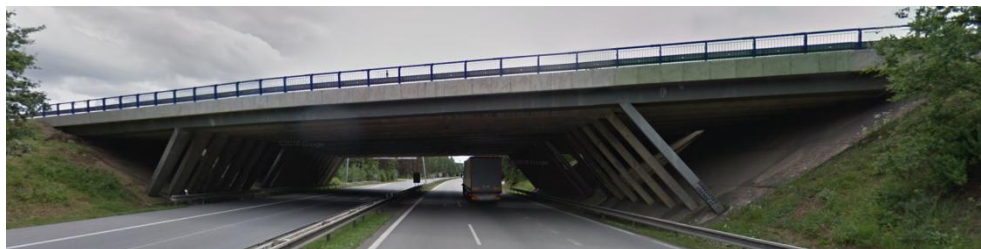
Obrázek 45: Most převádějící dálnici D1 km 112. [19]
