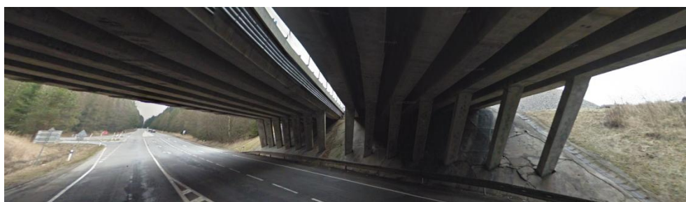
Obrázek 44: Bližší pohled na nadjezd na dálnici D1 km 119. [19]
