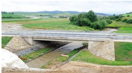
Obrázek 22: Integrovaný most nad Levočským potokem na polní cestě. [17]
