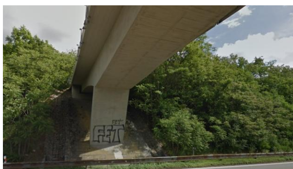
Obrázek 34: Bližší pohled na nadjezd na dálnici D1 km 182. [19]
