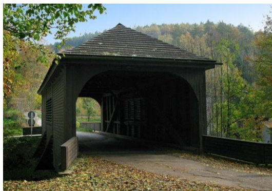
Obrázek 17: Dřevěný věšadlový most u Pekla nad Zdobnicí. [12]
