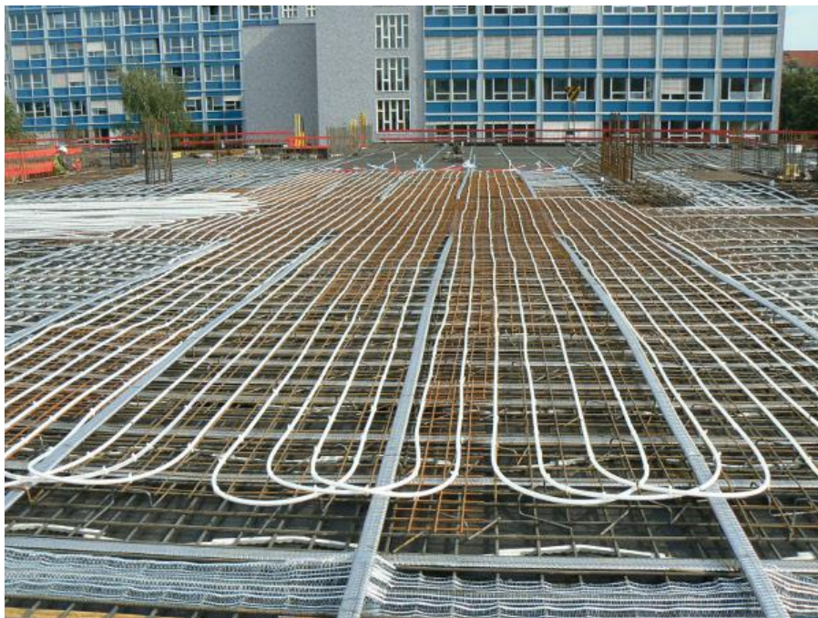
Obr. 2.24: Dodatečně předpínaná stropní konstrukce [29]
