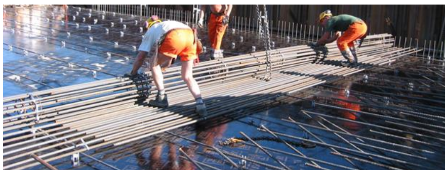
Obr. 2.19: Pokládání výztuže Bamtec [24]
