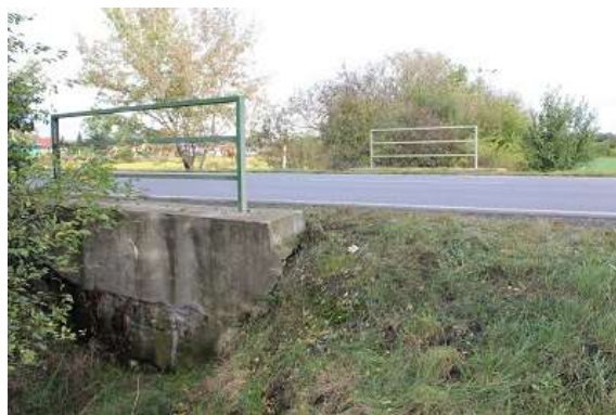
Foto č. 22 (Křížení toku se silnicí I. třídy 1/9)
