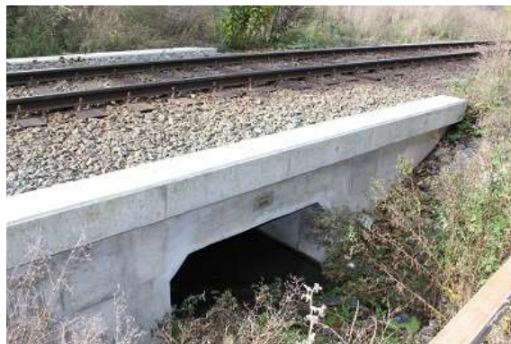
Foto č. 20 (Železniční most)
