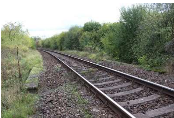
Foto č. 23 (Křížení toku železnicí)
