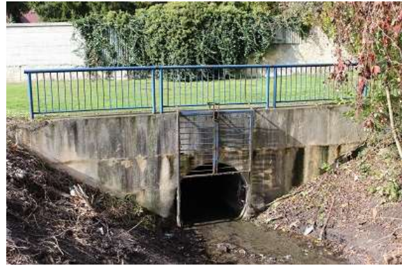
Foto č. 2 (zatrubnění část toku)
