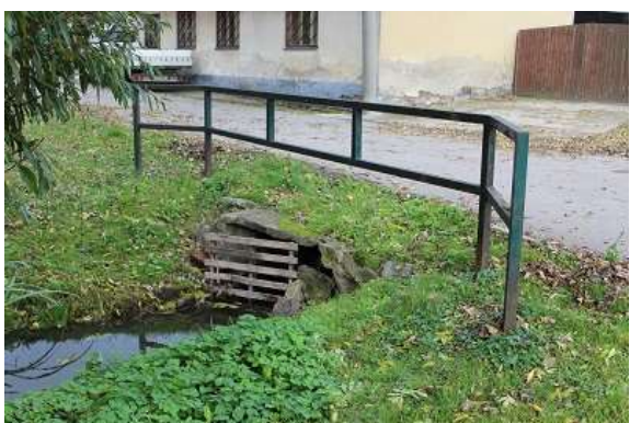
Foto č. 29 (Zatrubnění koryta v obci Předboj)
