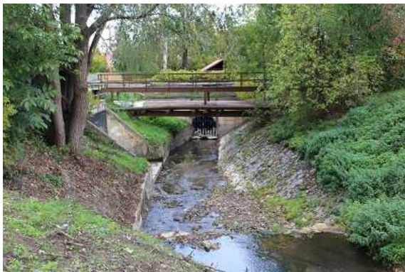
Foto č. 3 (Tok před zatrubněním)
