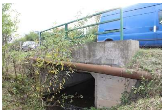
Foto č. 24 (Křížení toku se silnicí I. třídy 1/9)
