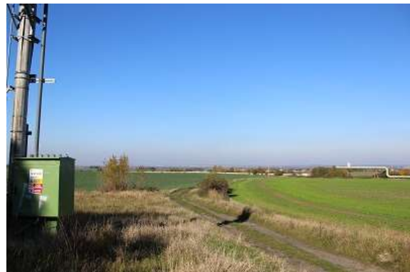
Foto č. 81 (Přemostění horkovodu)
