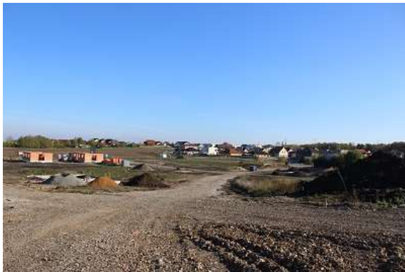
Foto č. 37 (Pohled na výstavbu v obci Předboj)
