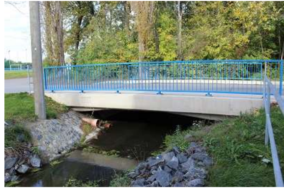
Foto č. 14 (most silnice III. třídy, Kojetice)
