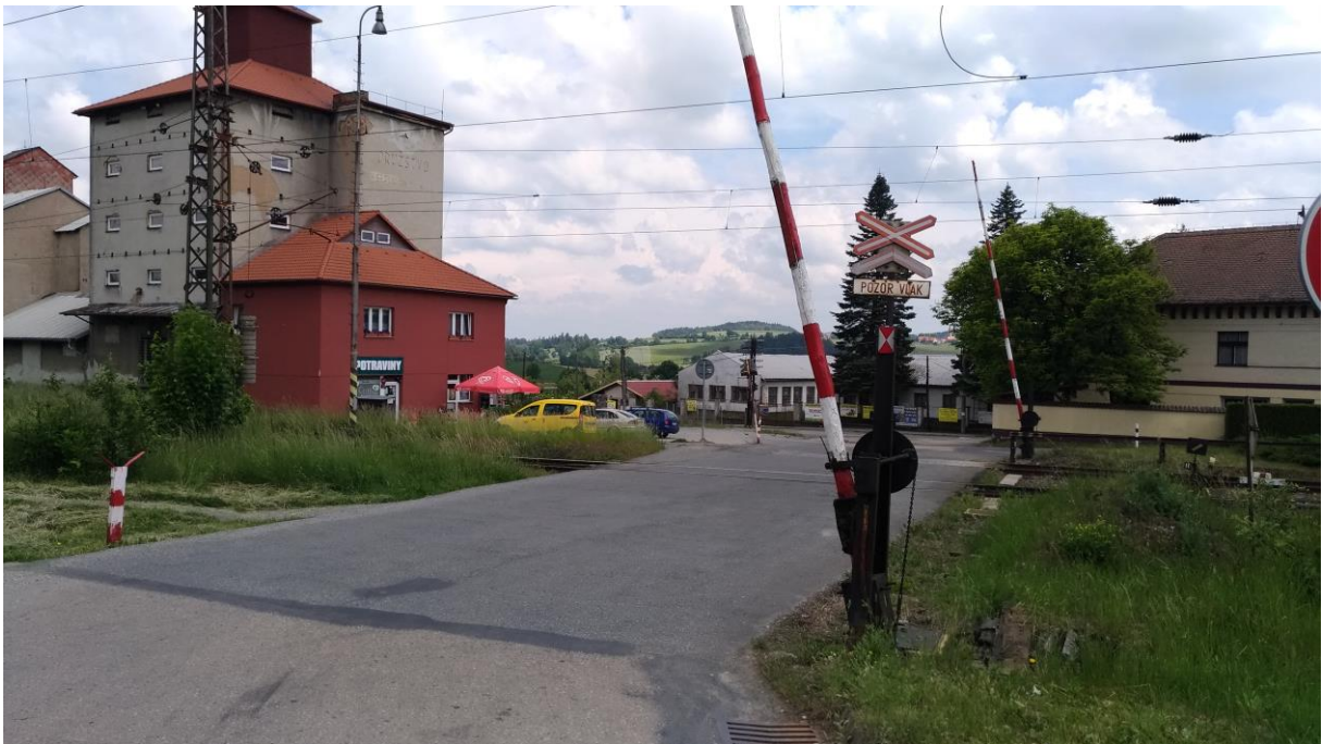
Obr. 14: Pohled na nevyhovující železniční přejezd uprostřed obce Heřmaničky
