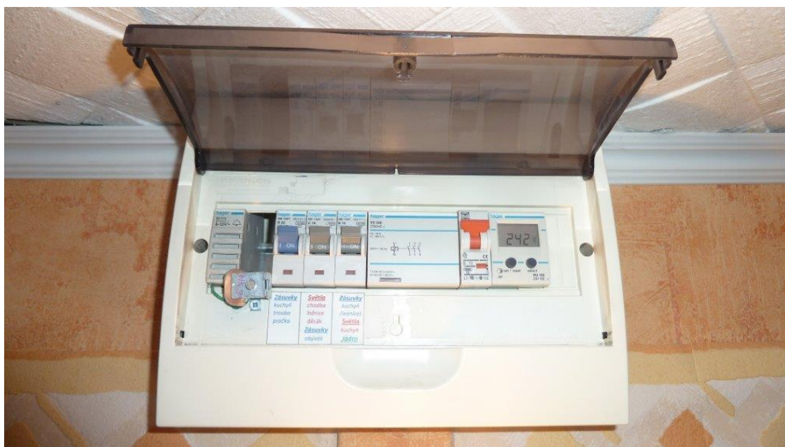
Obr. 15 - Podružný rozvaděč
