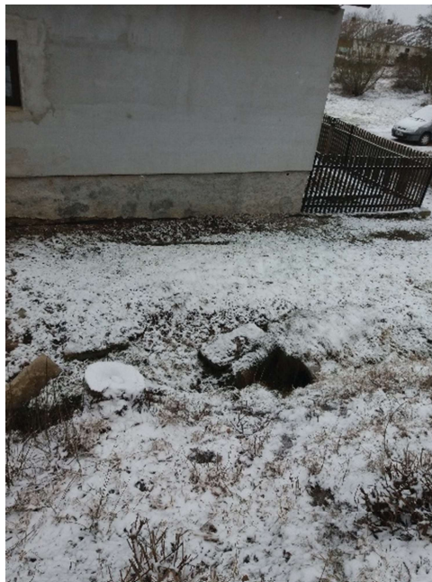
Obrázek 11 - Pohled na propustek z hráze MVN č.2., ř.km 6,925
