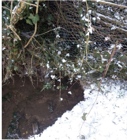
Obrázek 16 - Propustek DN 250 mm, ř.km 6,992 5
