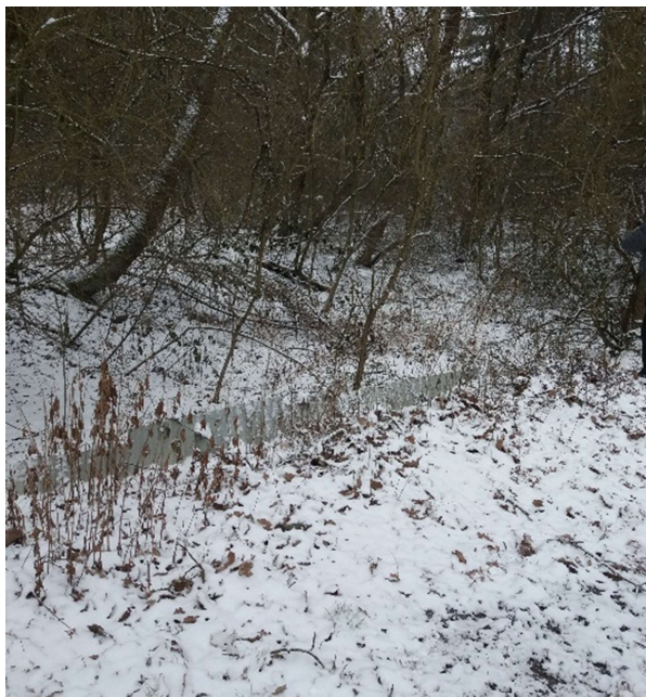
Obrázek 19 - Opevnění v.t. trapézovým plechem, ř.km 7,150 -7,165
