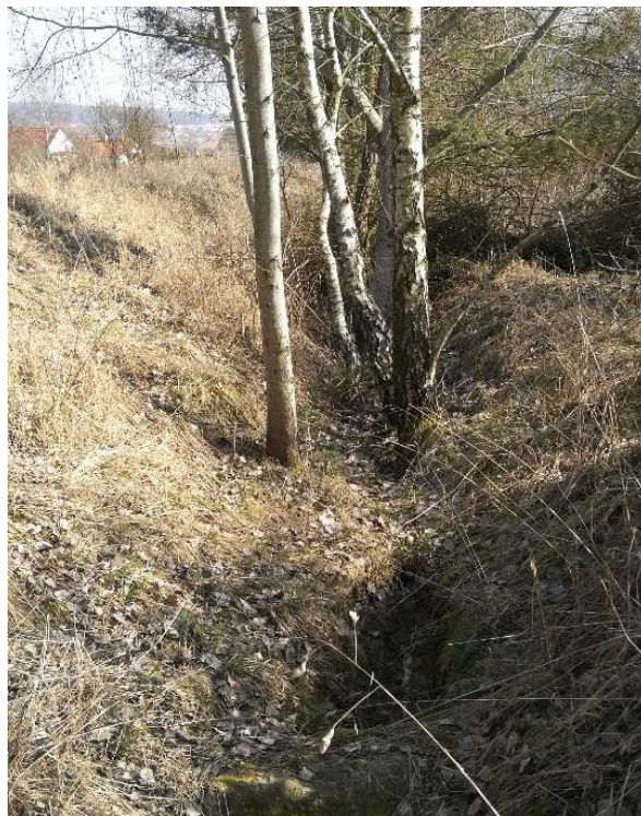
Obrázek 29 - Zarostlý průtočný profil Větve 2
