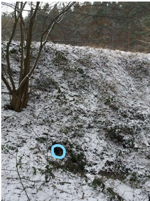
Obrázek 21- Pohled zespoda na hráz MVN č.1, znázorněna spodní výpusť z nádrže.
