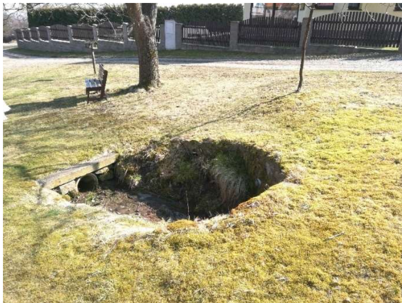
Obrázek 37 - Opevněný, otevřený příkop, staničení 55–60 m
