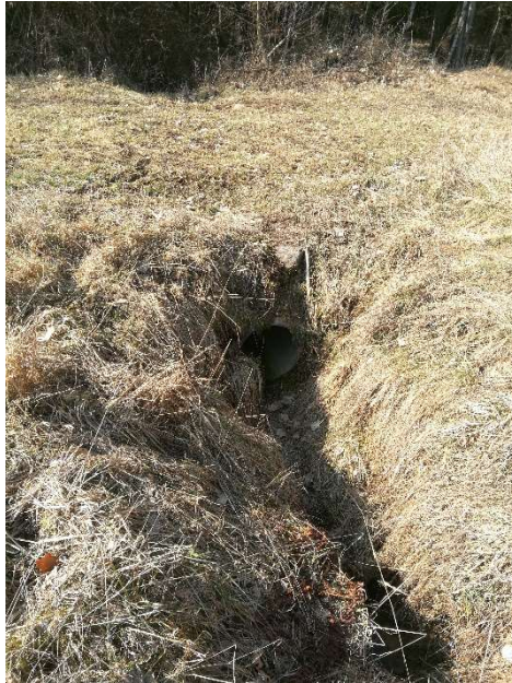
Obrázek 28 - Pohled na propustek, DN 500 mm
