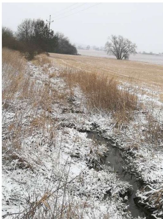
Obrázek 5- Pohled na koryto v.t. – úsek 1
