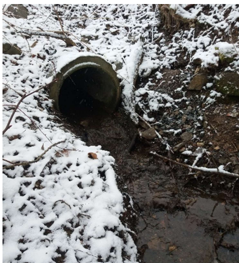
Obrázek 14 - Propustek DN 500 mm, ř.km 6,980
