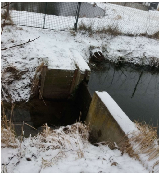
Obrázek 6 - Pohled na stavítko ř.km. 6,595 05
