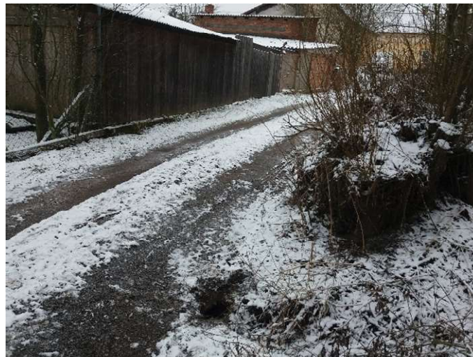
Obrázek 17 - Pohled na zaústění v.t., ř.km 7,150
