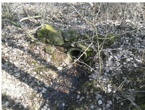
Obrázek 35 - Zatrubnění ve staničení 5 m
