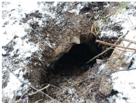
Obrázek 18 - Detailnější pohled na zaústění, ř.km 7,150
