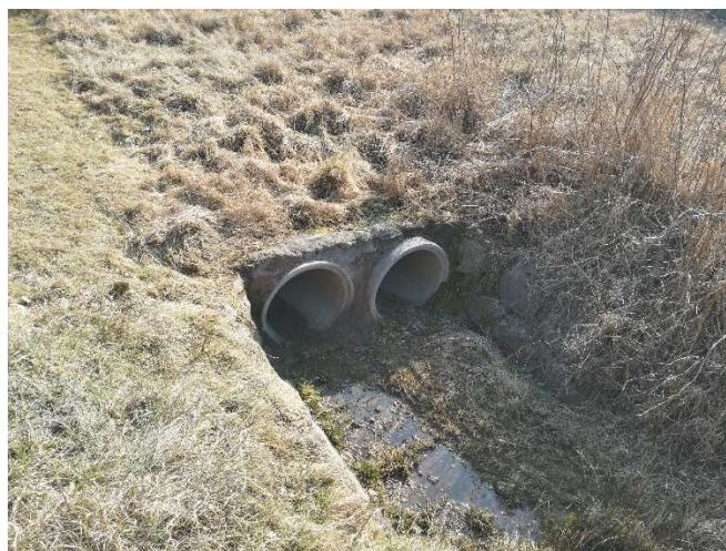
Obrázek 33 - Propustky Větvě 4, staničení 155 m, 2 x propustek o průměru DN 600 mm.
