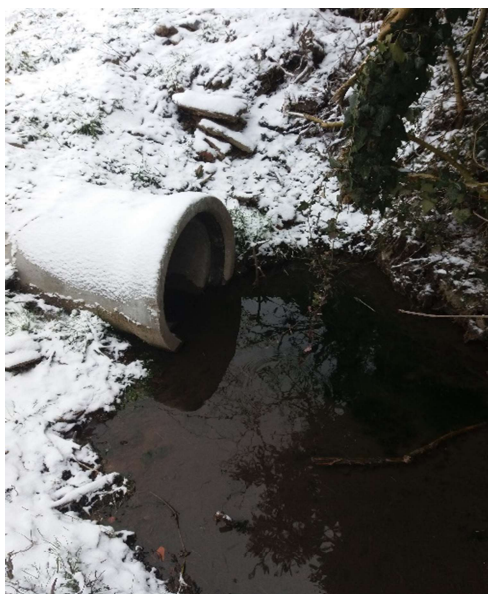
Obrázek 15 - Propustek DN 500 mm, ř.km 6,990
