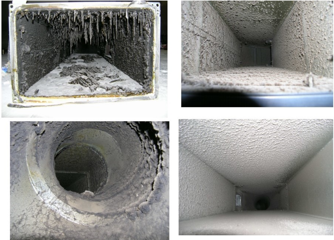
Obr. 20: Znečištěné potrubí [15]
