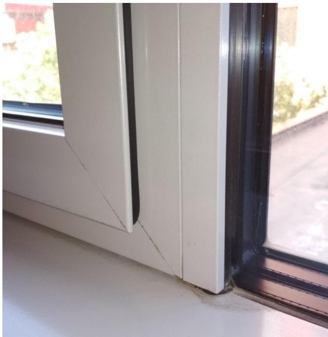
Obr. 9: Detail nového okna - FSv budova A (vlastní foto)
