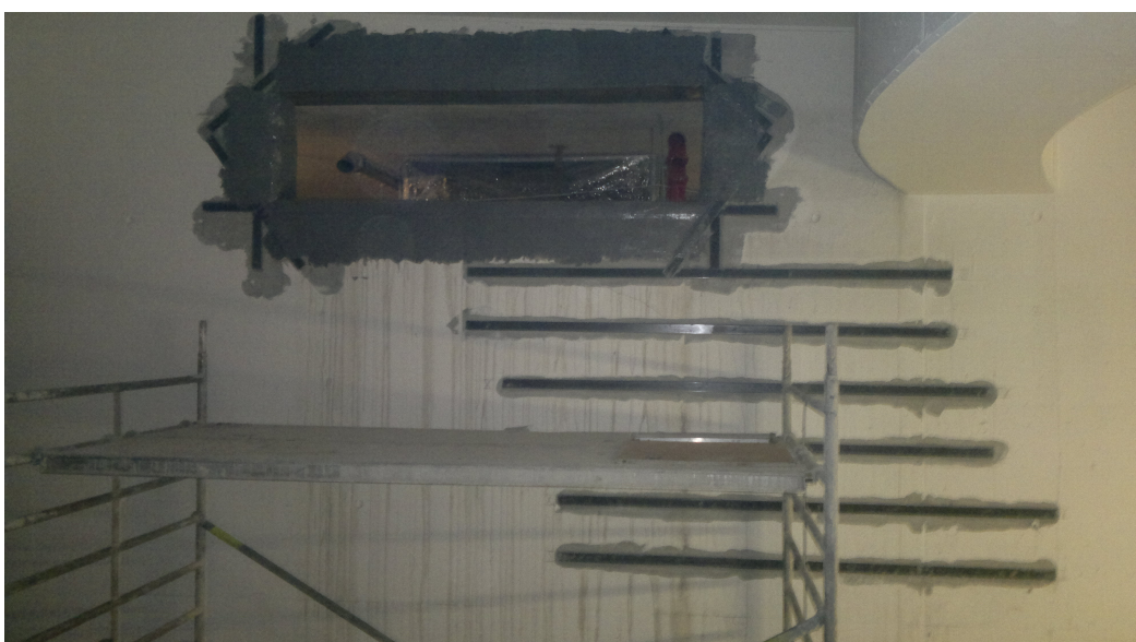
Obr. 29: Prostup konstrukce s lamelami a tkaninou (vlastní foto)
