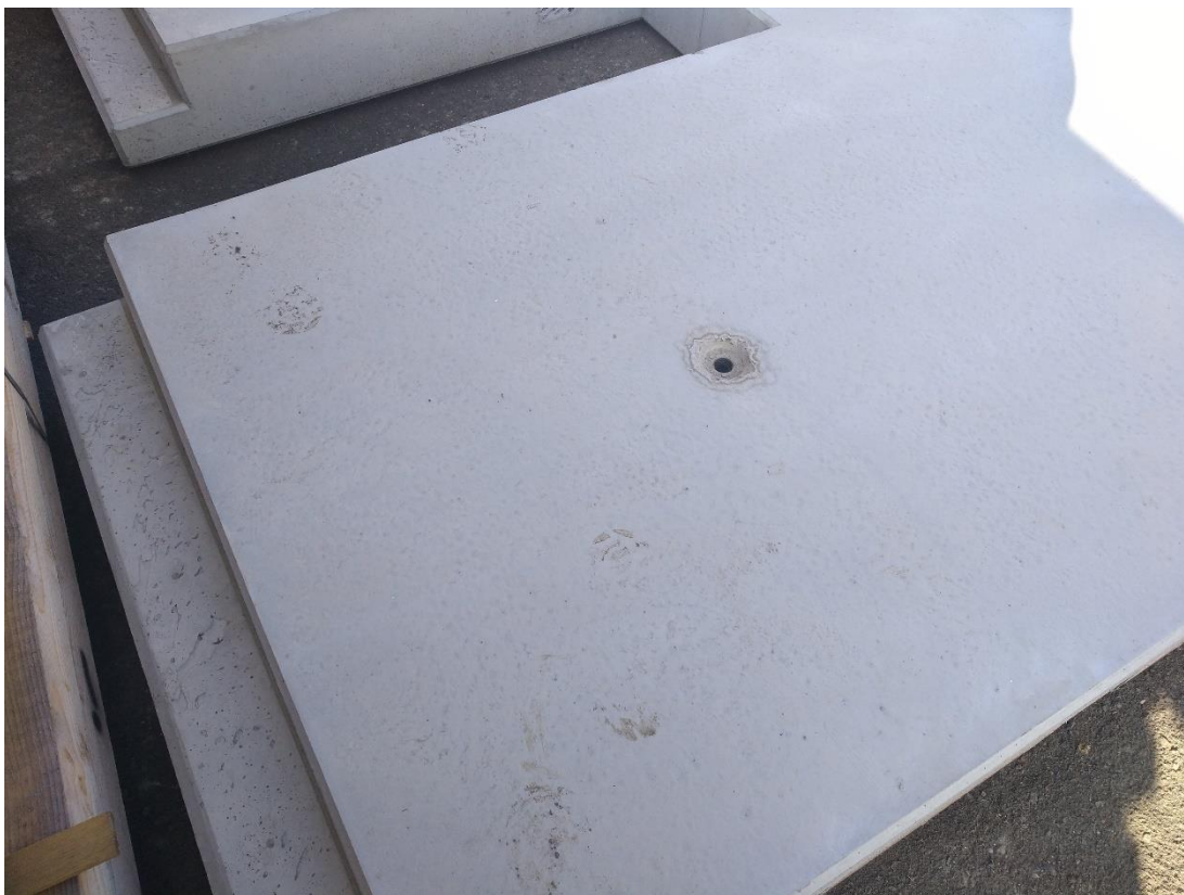
Obr. č. 12 Prefabrikovaná podesta s ozubem a montážním úchytem
