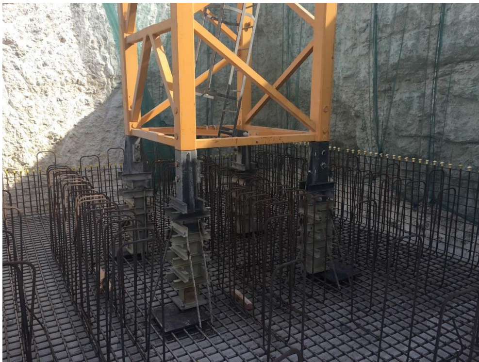
Obr. č.23 Ukotvení a založení věže jeřábu
