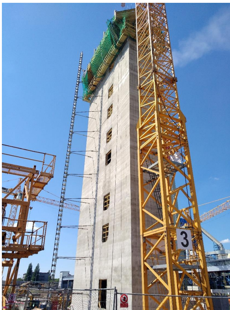
Obr. č.30 Pohled na ukotvení osobonákladního výtahu
