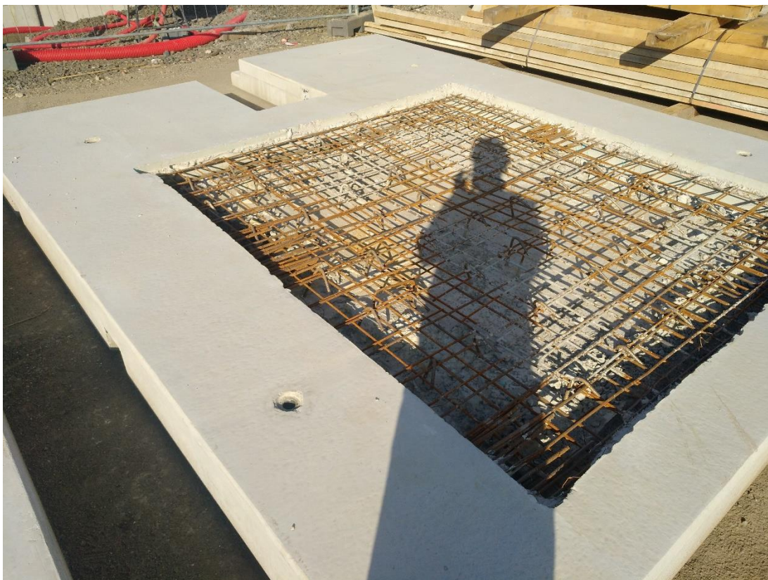
Obr. č. 13 Prefabrikovaná podesta s vybráním
