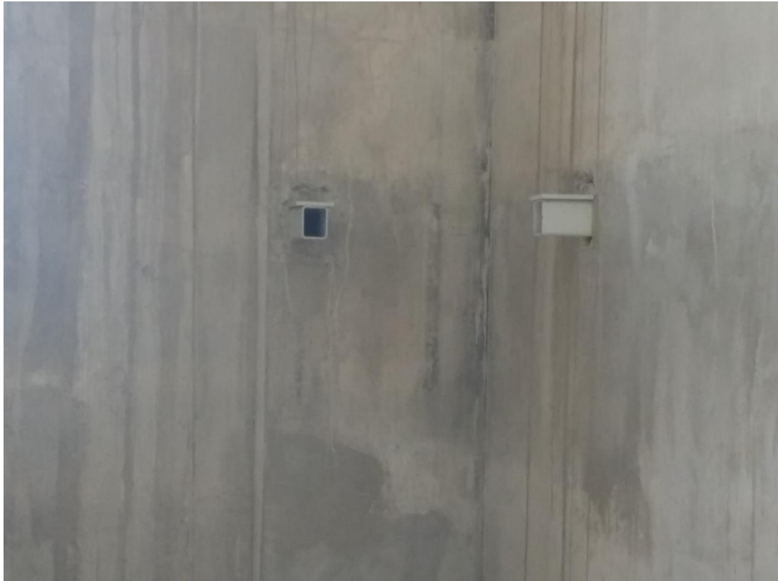
Obr.č.8 Vsazení uzavřeného ocelového profilu do kastlíků
