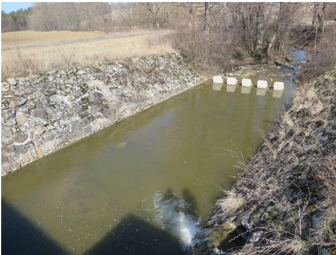
Obr. 3.6: Zaústění výpustného potrubí do odpadního koryta bezpečnostního přelivu
