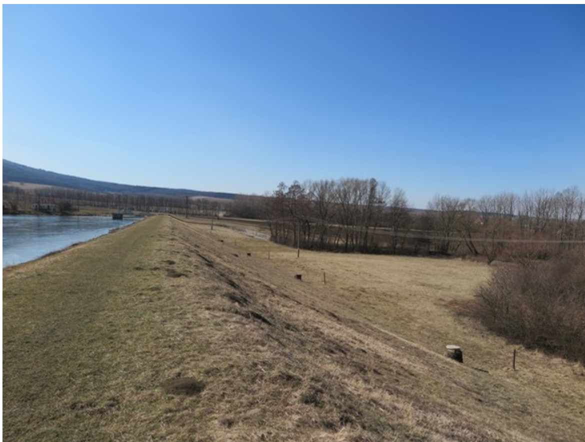
Obr. 3.3: Rozmístění kontrolních šachet drenážního potrubí
