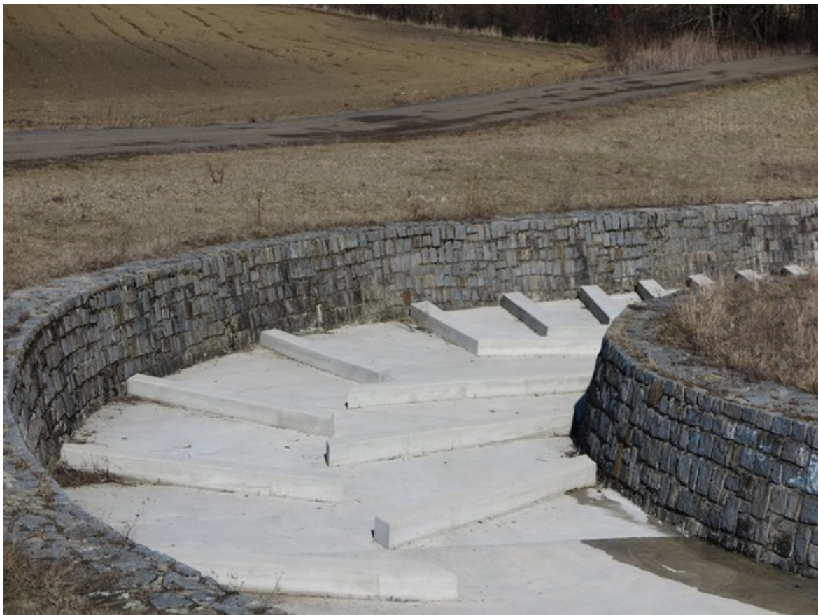
Obr. 3.8: Žebra pro zvýšení drsnosti
