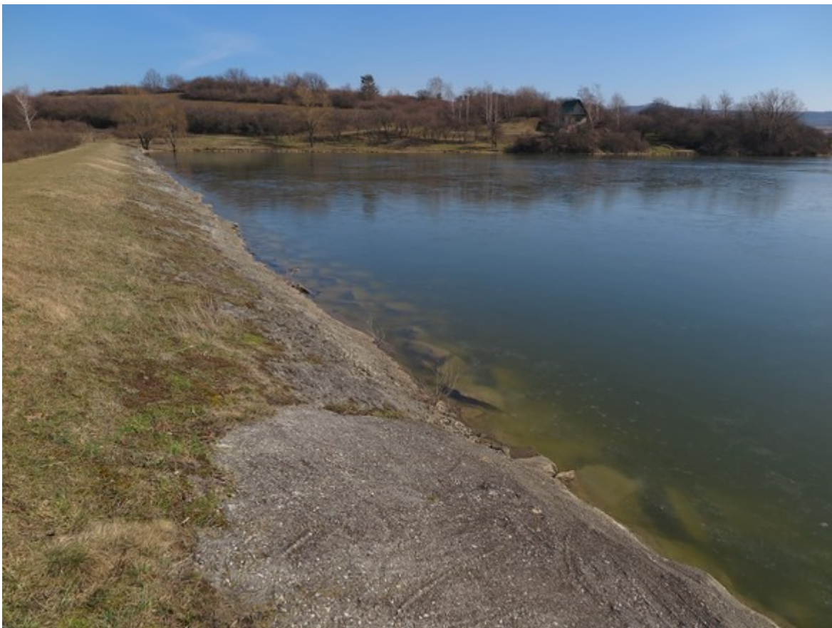
Obr. 3.2: Opevnění pohozelem s prolitím betonem
