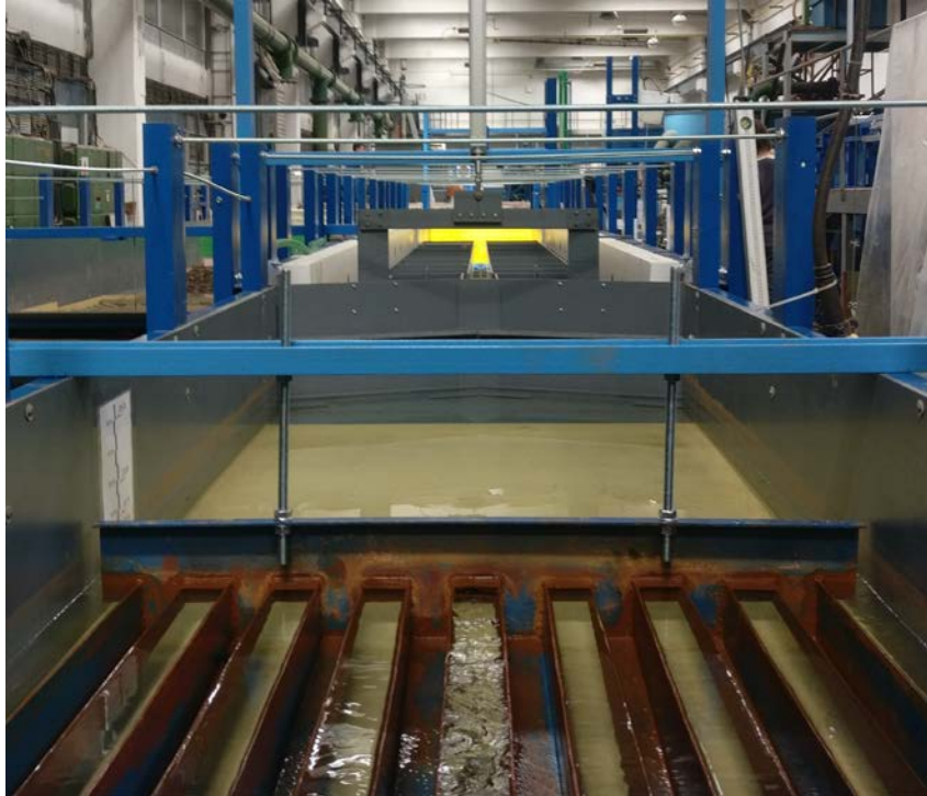
obr. 5.7 Fotografie labyrintového přelivu zajišťujícího hladinu dolní vody [zdroj: autor]
