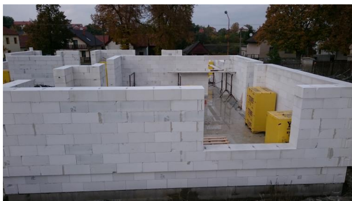
Obrázek 6.6.3-2-Hrubá stavba [autor]
