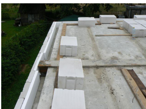
Obrázek 2.4.2-8-Strop Spiroll, krok 3
