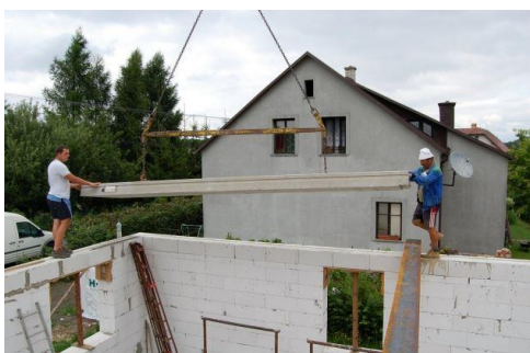
Obrázek 2.4.2-7-Strop Spiroll, krok 2
