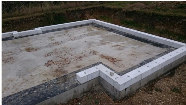
Obrázek 6.6.3-1-Pokládka 1. řady cihel [autor]
