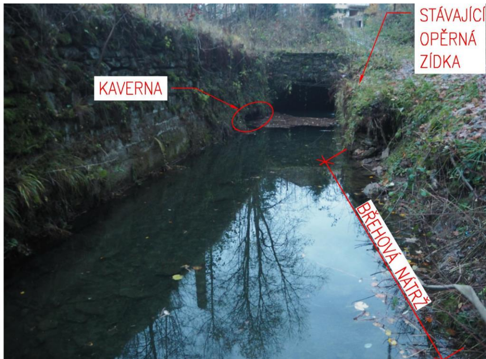
obr. 3.1 - Otevřený kanál, pohled proti vodě, podzim 2017
