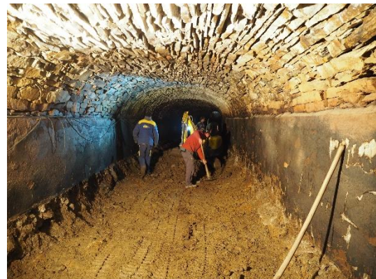
obr. 2.5 - Rekonstrukce dna př. kanálu
