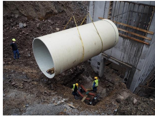
obr. 2.3 - Ukládání tlakového přivaděče
