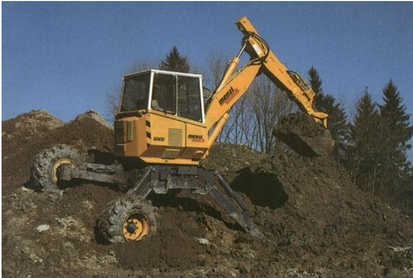
obr. 7.3 – Kráčející rypadlo Menzi Muck
