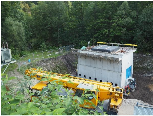
obr. 2.2 - Strojovna během realizace
