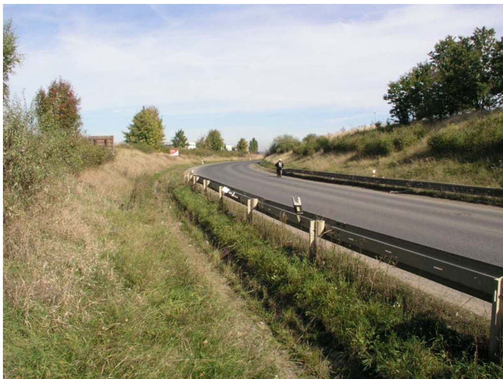
Obr. [5] Komunikace II/605 pohled do směrového oblouku
