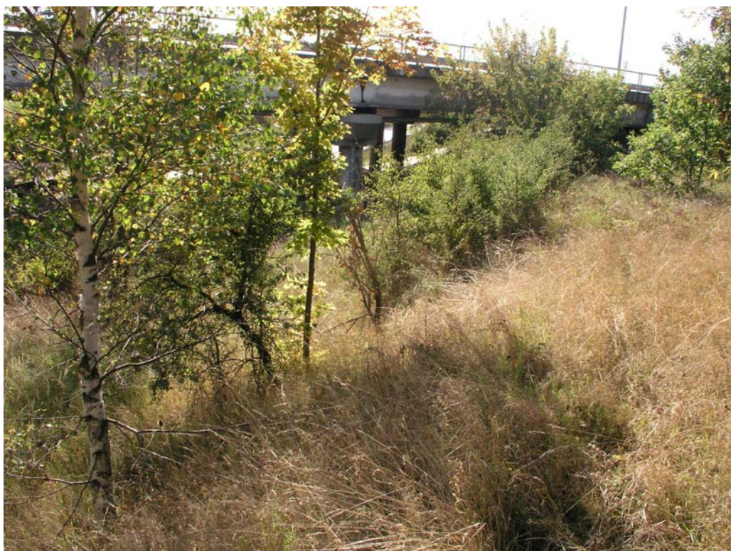
Obr. [6] Stávající křoviny ve svahu komunikace II/605
