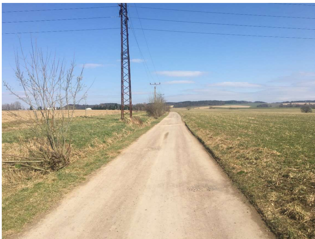
Obrázek 6: Mimoúrovňové křížení s polní cestou, Most na polní cestě
