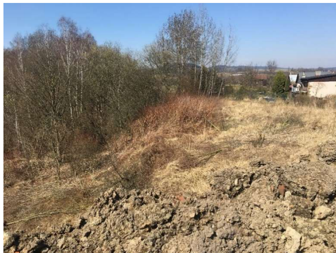
Obrázek 15: neúnosné podloží, opěrná zeď
