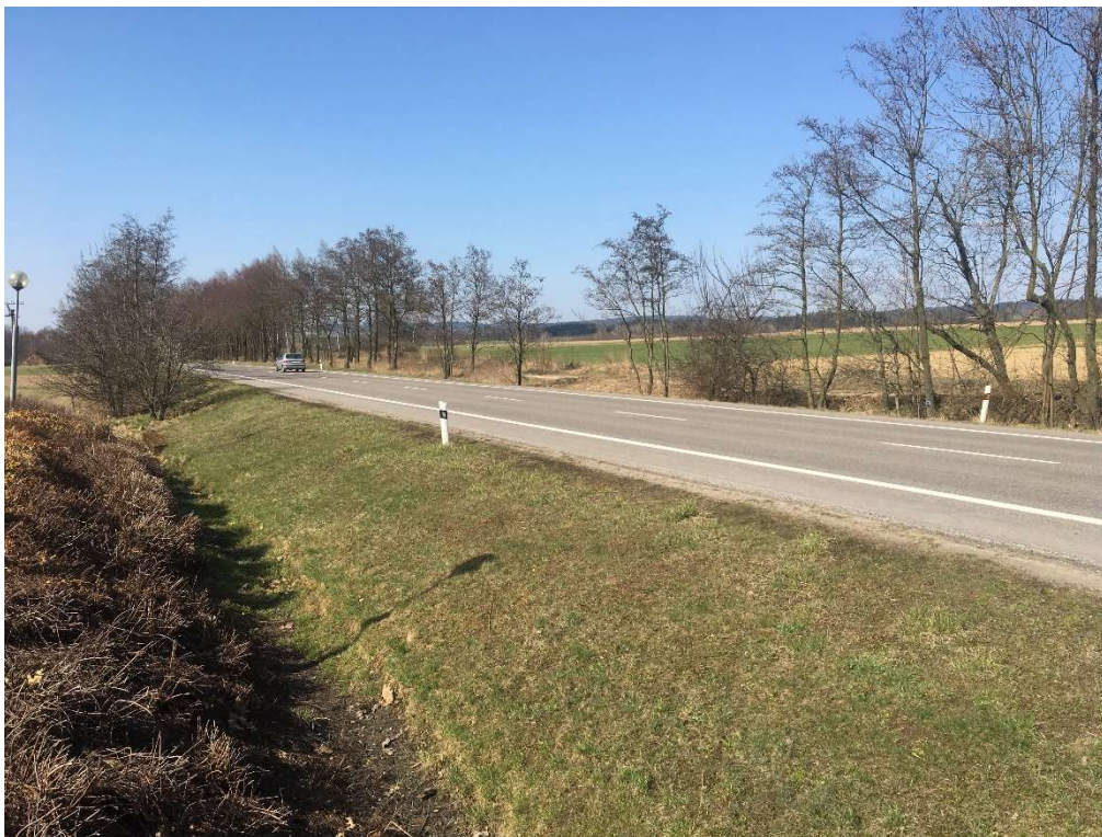
Obrázek 1: začátek přeložení silnice I/14
