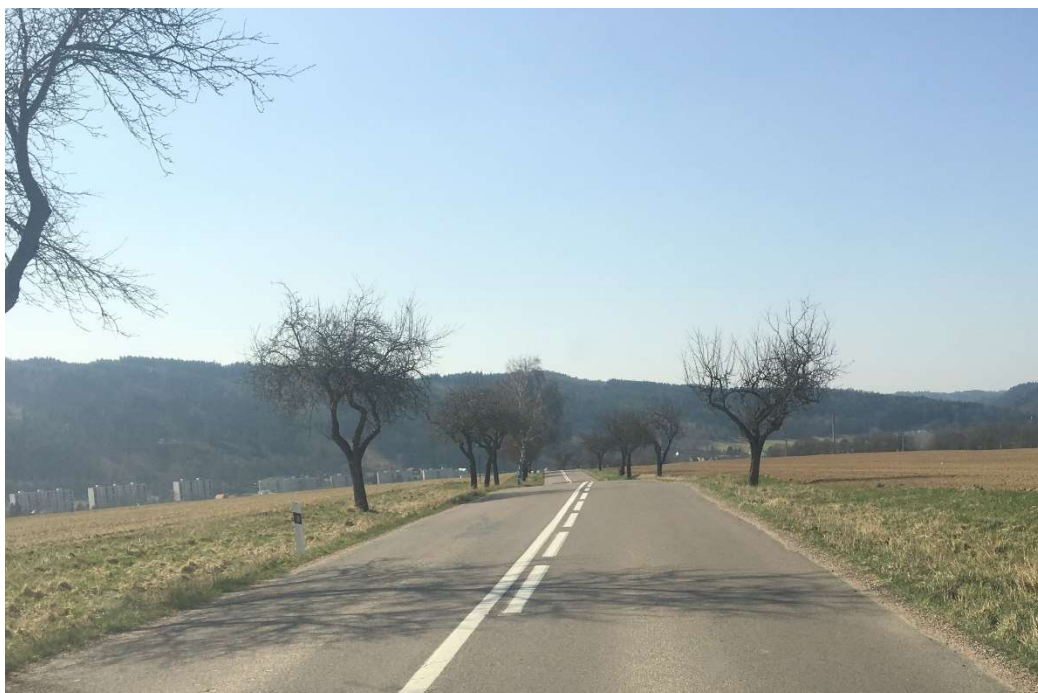
Obrázek 2: silnice II/315, mimoúrovňové křížení
