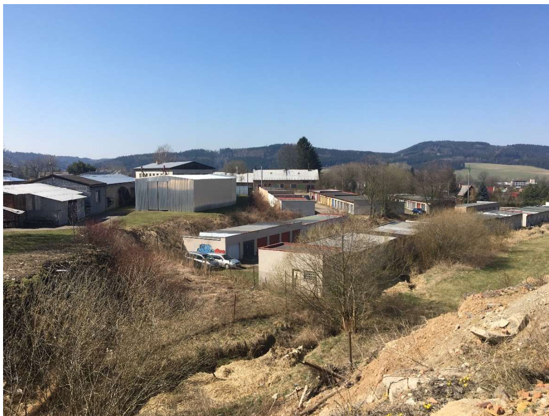
Obrázek 43: kolize s garážemi, most přes vodoteč
