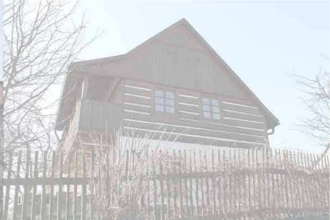
STÁVAJÍCÍ OBJEKT UPROSTŘED VSI
