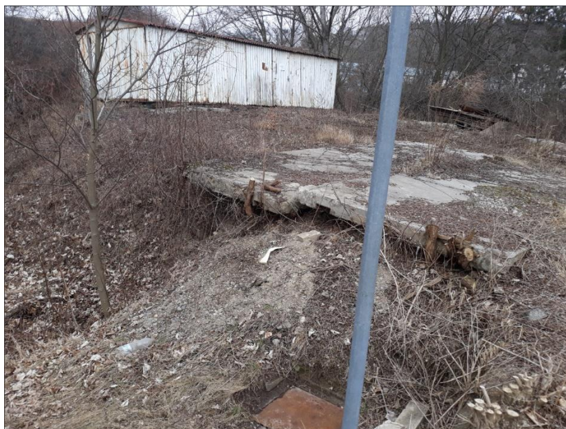
Obr.č. 30: Fotografie ukazující pozůstatky betonových panelů, sloužících jako základová deska pro dnes již neexistující objekt. Dále můžeme vidět na fotografii vlevo na hoře objekt (nejspíše skladovací hala), který je nepoužívaný a chátrá a je jen otázkou času, než se stane nebezpečným. Dále je ještě možné vidět v pravém horním rohu neuklizená prkna, která degradují a stanou se nepoužitelnými.
