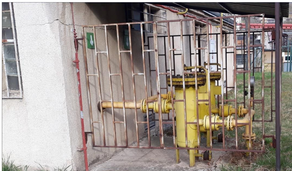
Obr.č. 13: Fotografie filtrů před PRS VTL/STL, NTL. Pozn.: U filtrů se nachází i uzávěry přívodu zemního plynu. Z důvodu dostupnosti pro hasiče, má být toto místo označeno a zcela zpřístupněno. Z důvodu bezpečnosti a hrozby terorismu je stanoven protikladný požadavek, který požaduje místo zabezpečit před vniknutím cizích osob a co nejvíce znesnadnit jeho nalezení. Na obrázku je vidět kompromisní řešení, realizace protichůdných požadavků.
