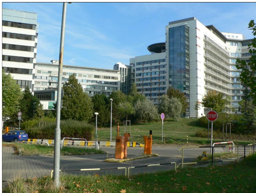
Obr.č. 36: Obrázek ukazuje jedno z parkovišť (které by mohlo být nahrazeno parkovacím domem) a jeho okolí. Na obrázku je vidět i vybavení areálu FNM heliportem, což ukazuje snahu FNM držet krok s trendy a být nemocnicí na vysoké úrovni.
