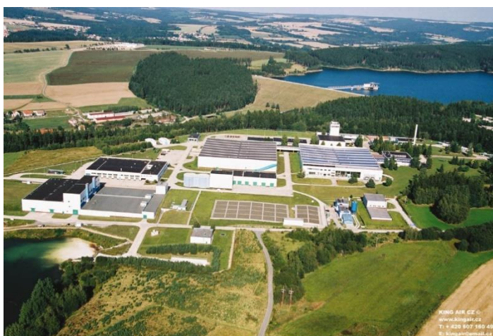
Obr. č. 22: Obrázek leteckého snímku úpravní vody Nesměřice
