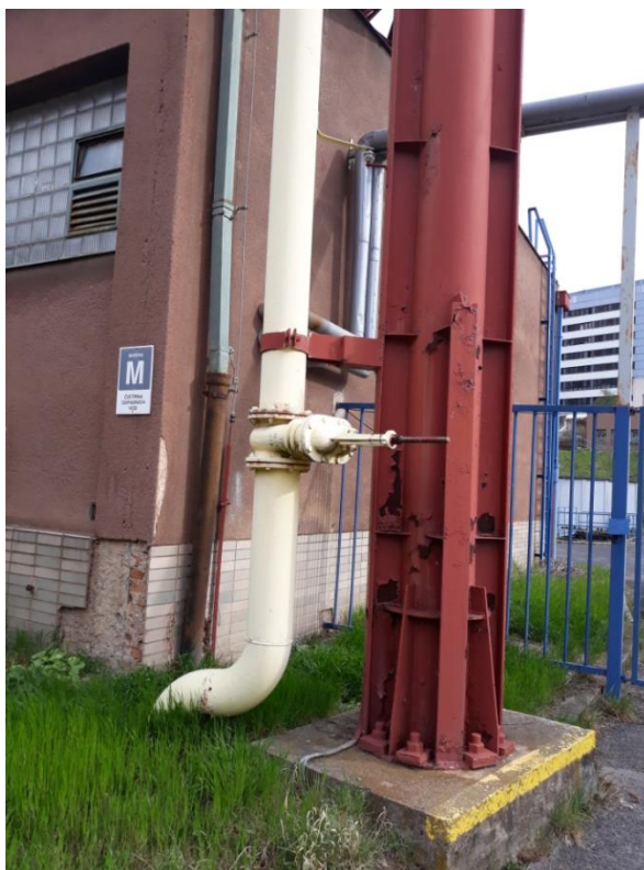
Obr.č. 10: Fotografie NTL potrubního vedení u ČOV vystupující nad terén
