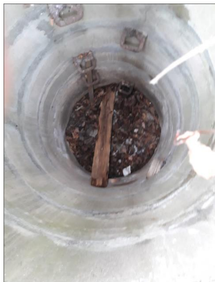
Obr.č. 32: Vnitřek „zapomenuté“ revizní šachty z obrázku č.31
