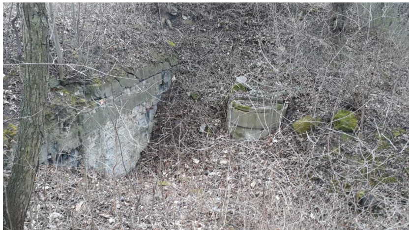
Obr.č. 31: Na fotografii je vidět „zapomenutá“ revizní šachta, která by mohla v budoucnosti způsobit komplikace, například při nové výstavbě
