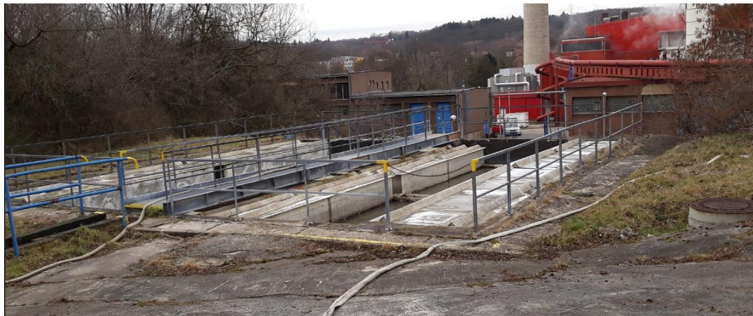
Obr.č. 20: Fotografie usazovací nádrže v areálu FNM
