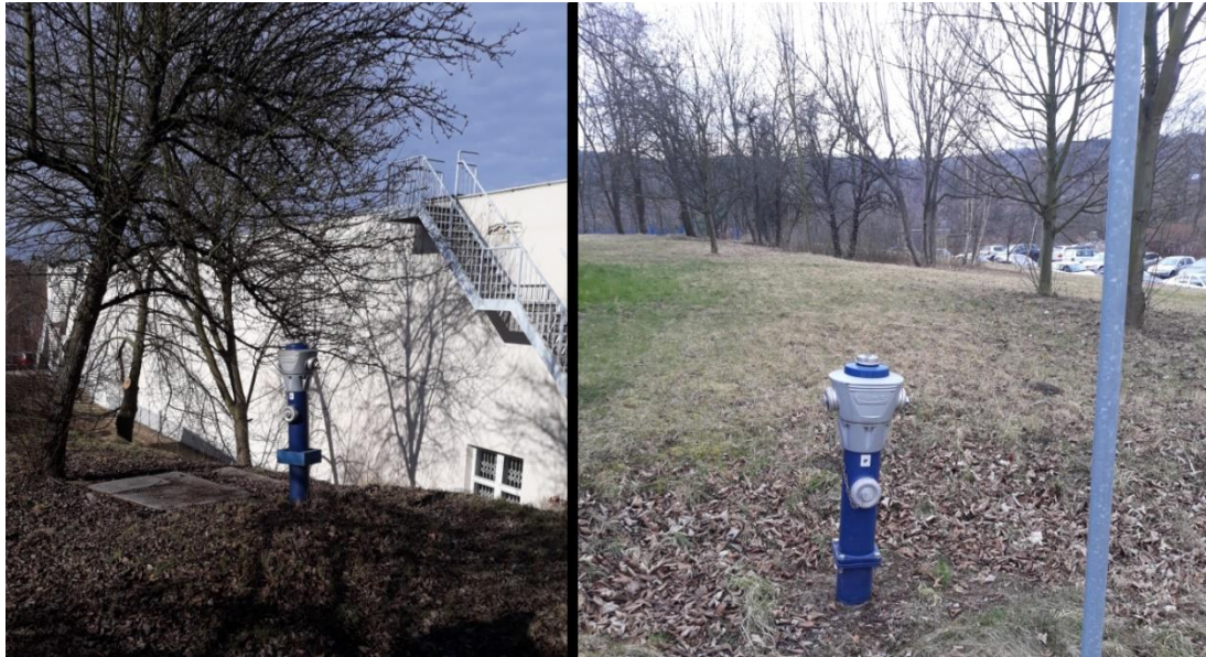
Obr. č. 28 : Příklady umístění nadzemních hydrantů. Hydrant vlevo není optimálně umístěn, přístup například hasičským vozům k němu stěžují neudržované dřeviny. Opačná situace je vidět u hydrantu vpravo, kde je hydrant na volné ploše, v jehož blízkosti je pouze sloupek s tabulkou (na tabulce je označení hydrantu a číslo příslušného hydrantu), který v případě potřeby mohou hasiči velmi snadno odstranit.
