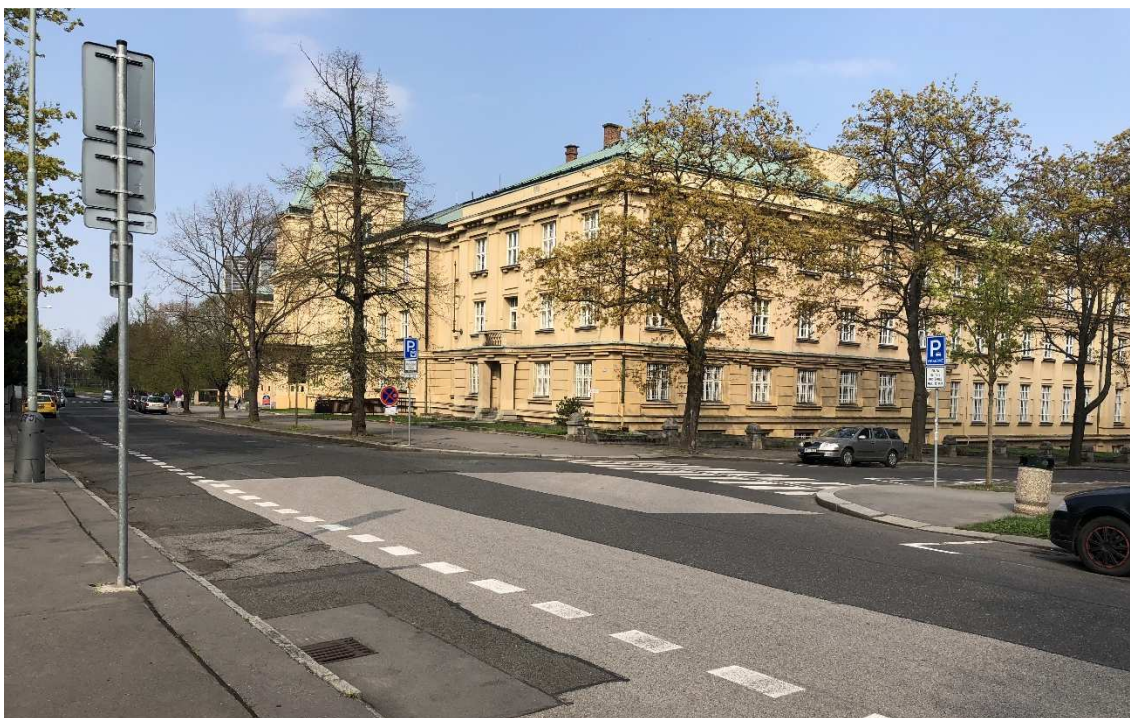
Obr. 34 - Pohled na sledovanou křižovatku z Kolejní ulice
