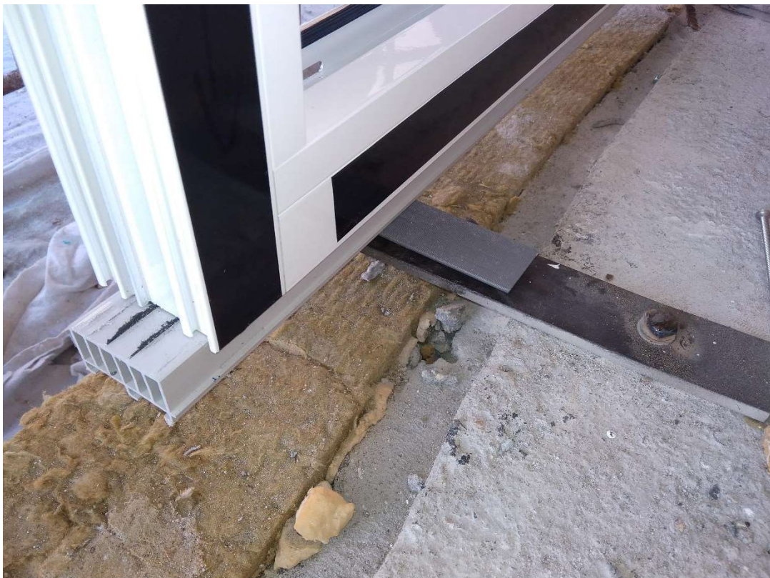
Obr. 33 Vykonzolování pomocí ocelových pásovin (11.4.2018)
