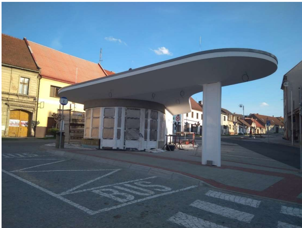
Obr. 37 Aktuální stav provádění – pohled z exteriéru (30.4.2018)
