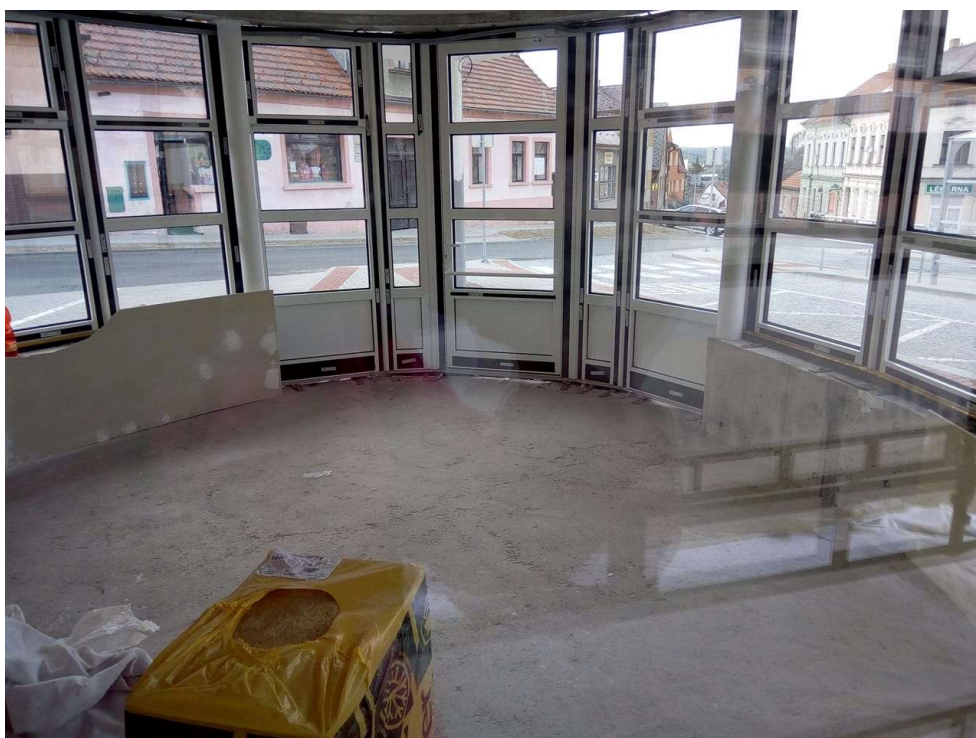
Obr. 38 Aktuální stav provádění – pohled z interiéru (30.4.2018)
