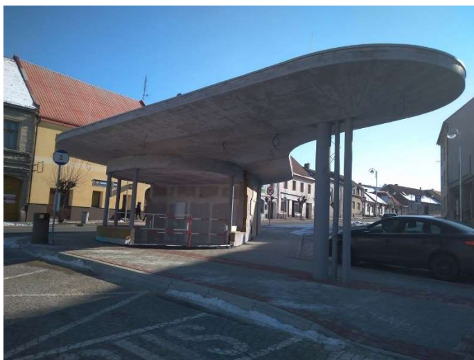
Obr. 1 Čekárna v průběhu stavby (25.2.2018)
