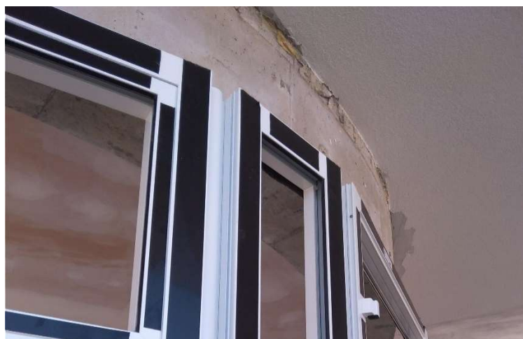
Obr. 35 Variabilní roh před zateplením a zakrytím (11.4.2018)
