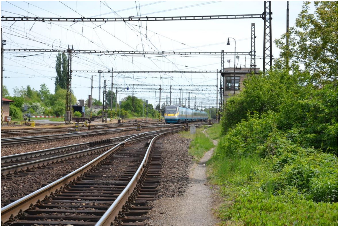
Obrázek 55: Stavědlo 2 s elektromechanickými přístroji na pomezí osobního a předjízdného nádraží
