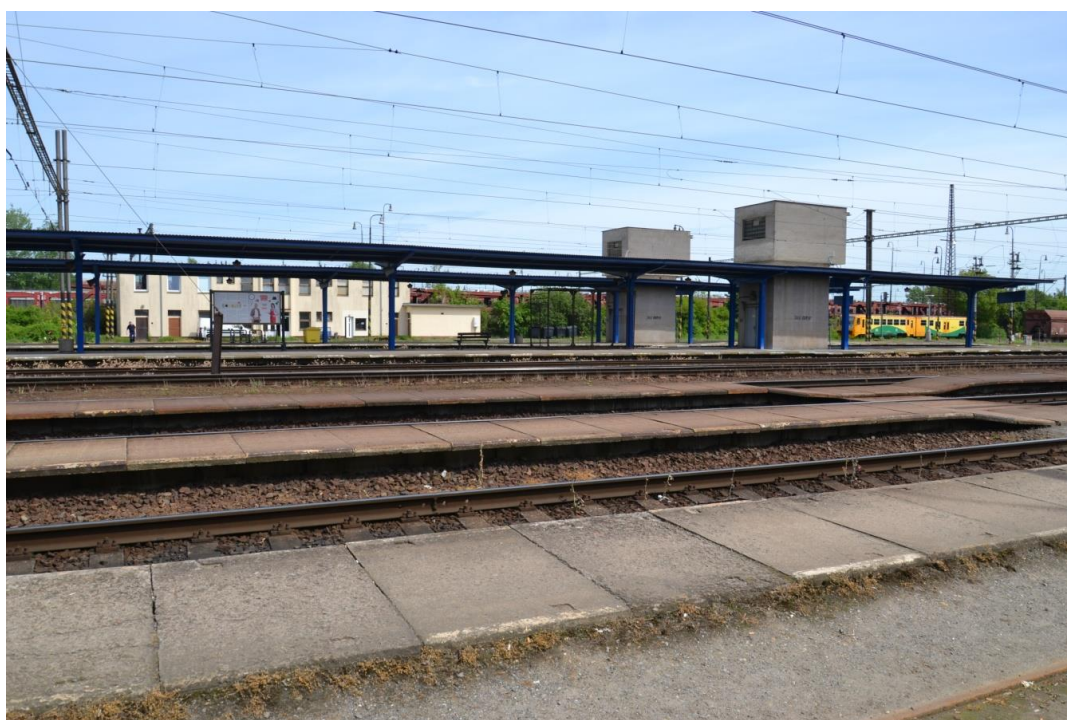
Obrázek 52: Nákladní výtahové šachty
