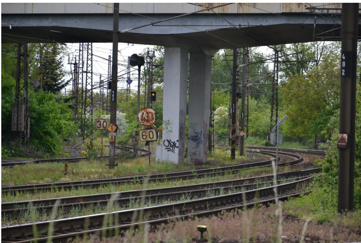
Obrázek 67: Pohled od výpravní budovy ku Praze směrem k silničnímu nadjezdu
