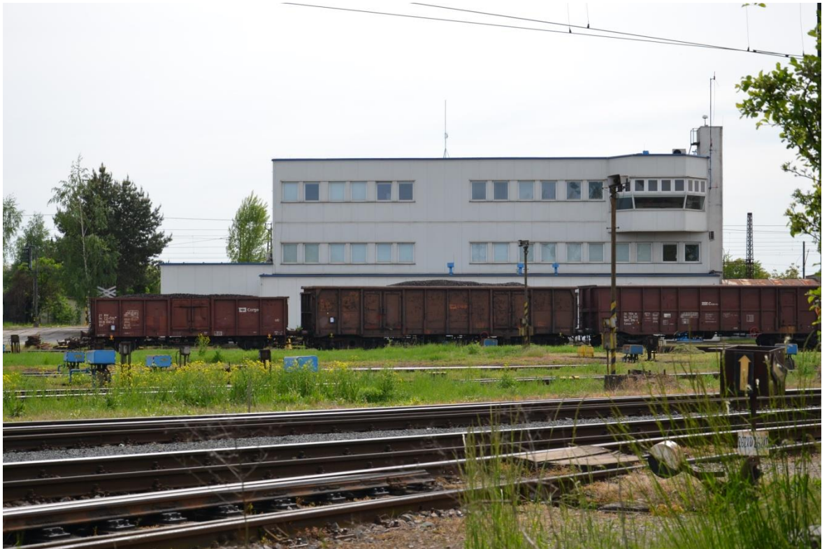
Obrázek 62: Budova stavědla KOMPAS – automatického zab. zař. spádovišť
