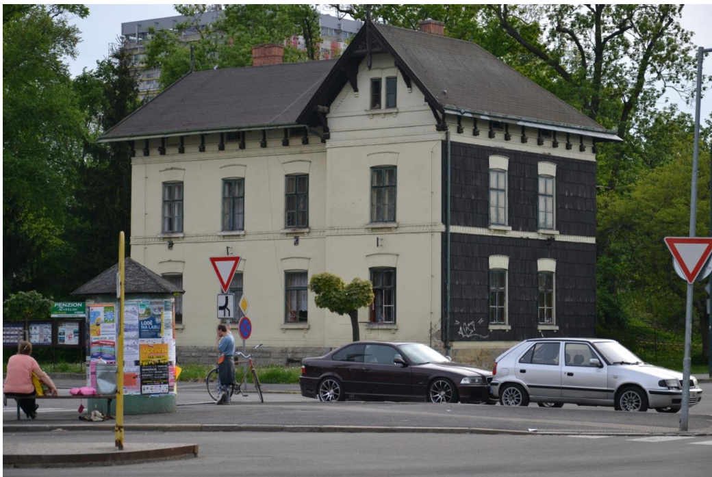
Obrázek 46: Jedna z budov vystavěných jako součást železniční kolonie pro zaměstnance dráhy
