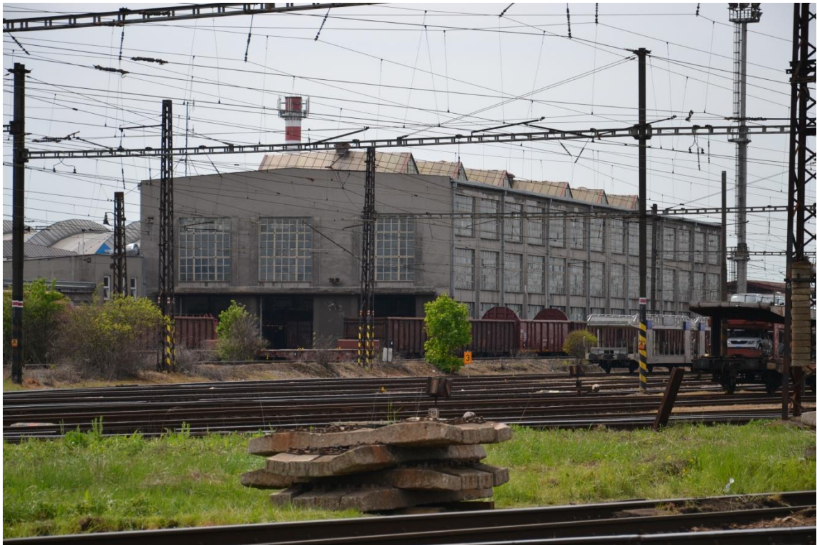
Obrázek 60: Opravny kolejových vozidel
