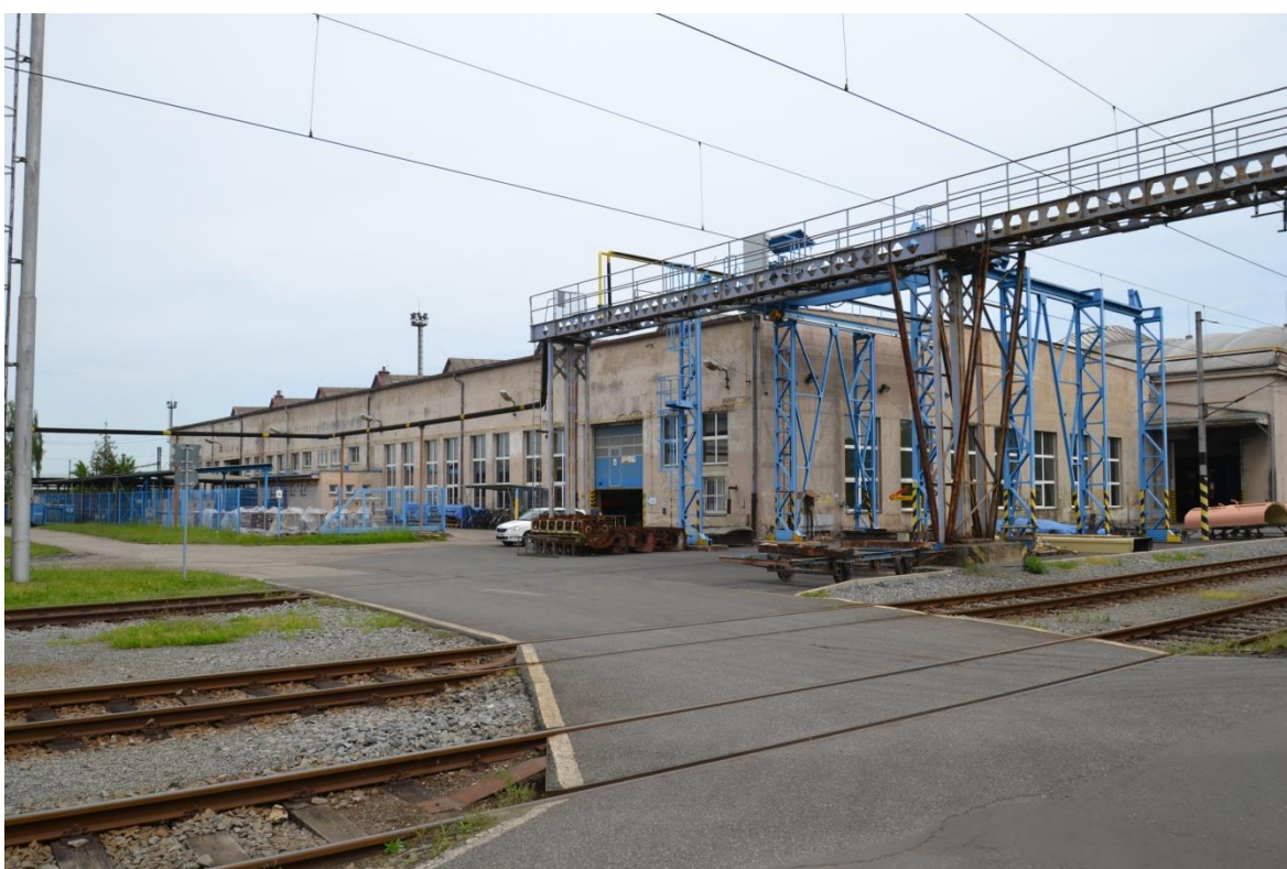
Obrázek 58: Opravny kolejových vozidel
