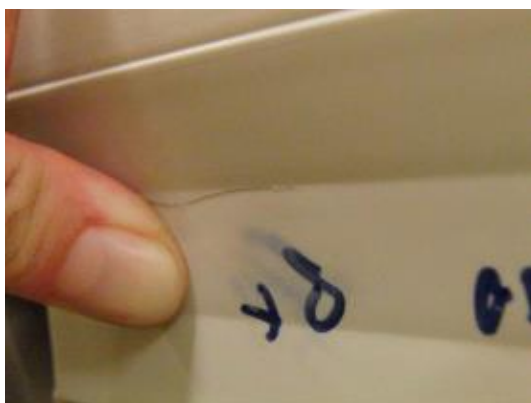
Obrázek 6.5: Detail poškození - mírná prasklina
