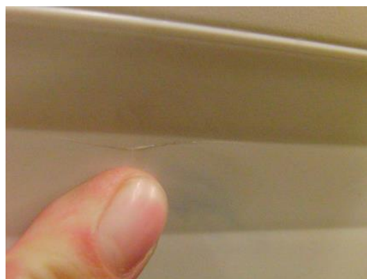
Obrázek 6.6: Detail poškození - mírná prasklina
