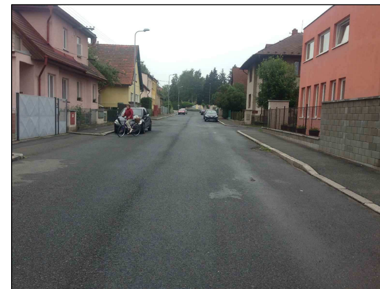
Obr. 46: Současný stav ulice Smetanova směrem od nádraží
