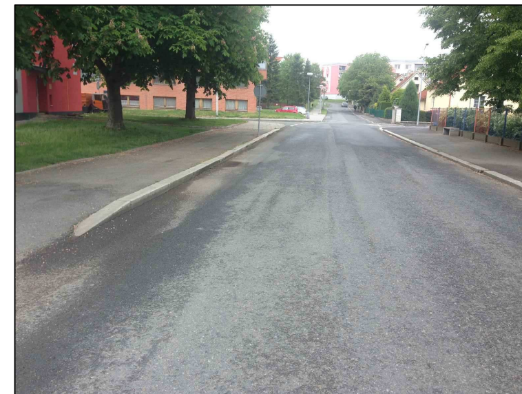
Obr. 56: Současný stav ulice Loretská v blízkosti budovy hasičů
