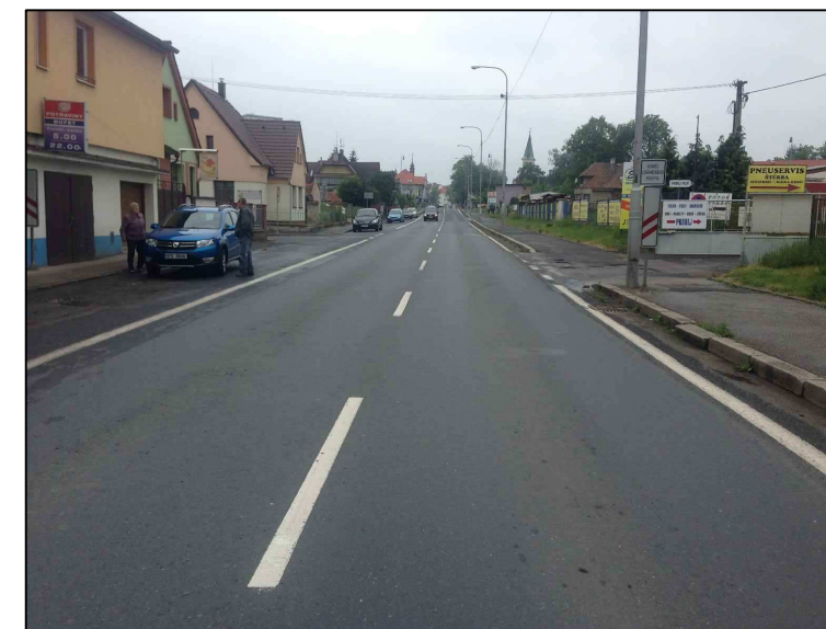
Obr. 50: Současný stav ulice Strakonická - pohled k železničnímu přejezdu
