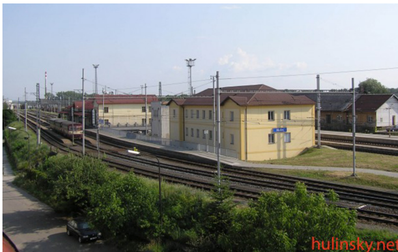
Obr.21: Pohled na stanici Hulín na kroměřížské nástupiště (foto: hulinsky.net)
