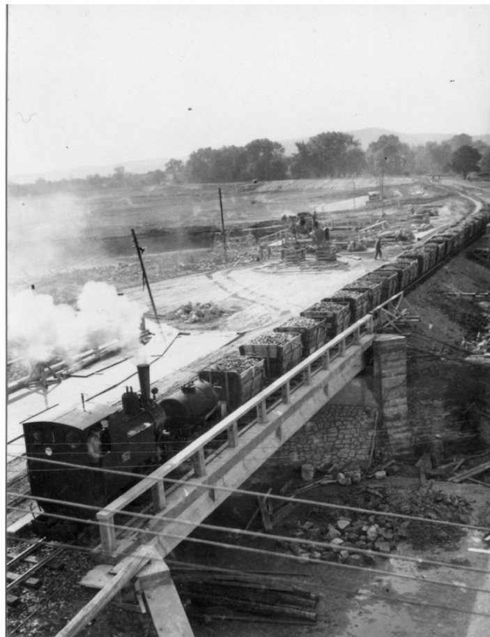
Obrázek 12 - Podzim 1954 – vláček na novém betonovém mostě stále ještě slouží k dopravě řepy na překladiště v Libněvsí, odkud se odváží do cukrovaru [5]
