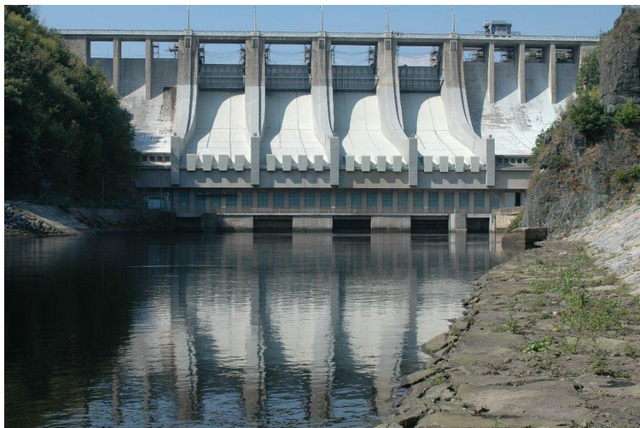
Obr. 2.5 Vodní elektrárna Slapy [17]
