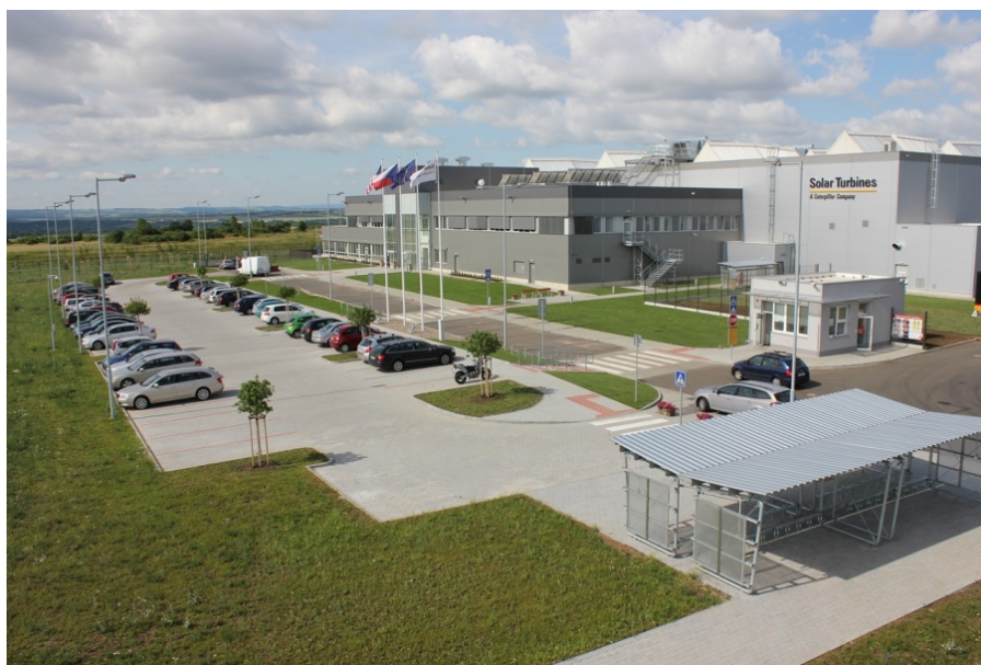
Obrázek 2.2: Opravárenské centrum v Žatci
