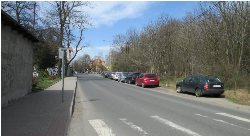
obr. 15: Parkování na nezpevněné ploše při pozemní komunikaci (ul. M. Horákové, jihovýchodně od VB)
