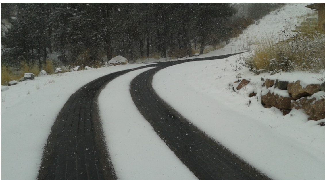
Obrázek 13: Samorozmrazující se silnice
