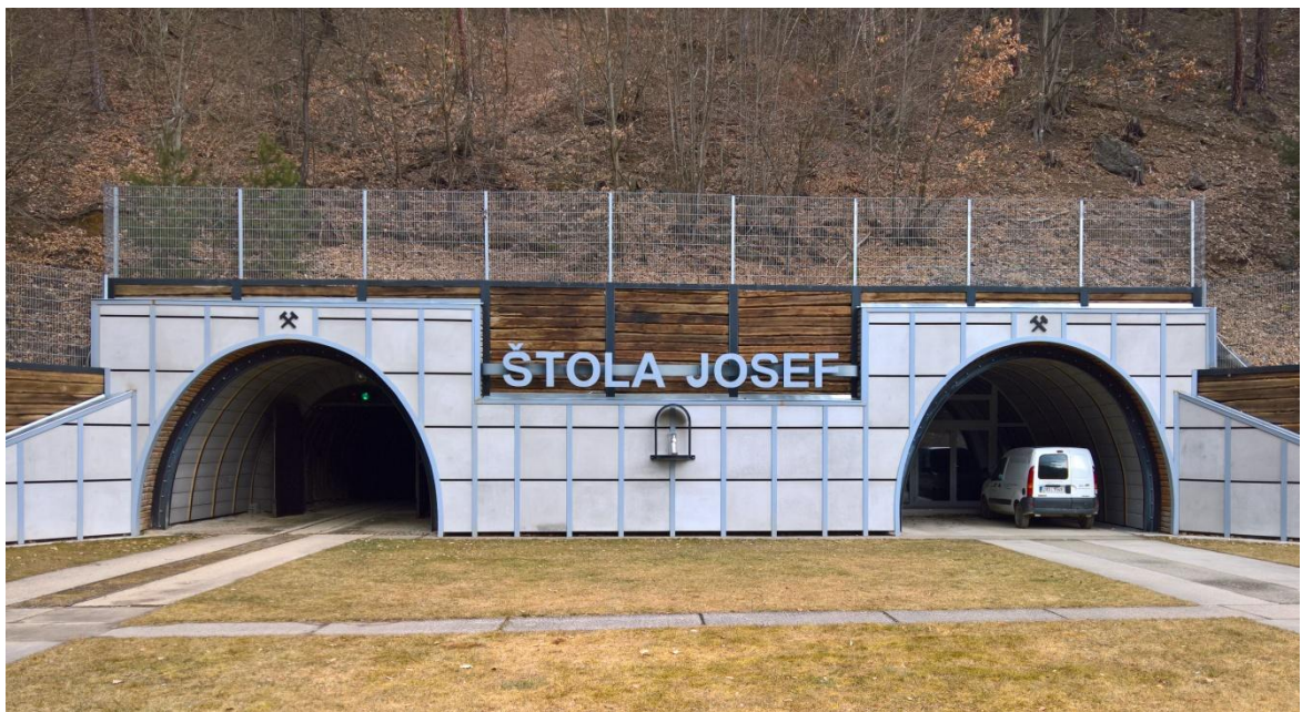
Obrázek 2 Vstupní portály Štoly Josef (současný stav)
