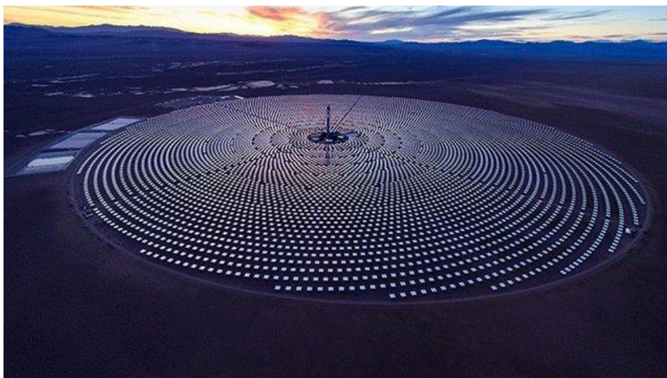
Obrázek 8 Crescent Dunes v americké Nevadě poblíž města Las Vegas jejíž výkon je 110 MW
