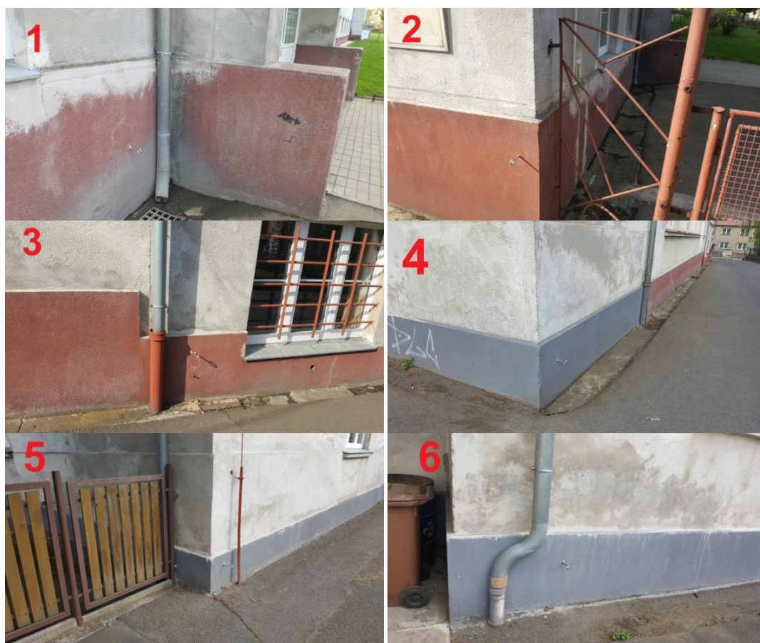
(obr. 15 Stabilizace bodů 1 až 6)
