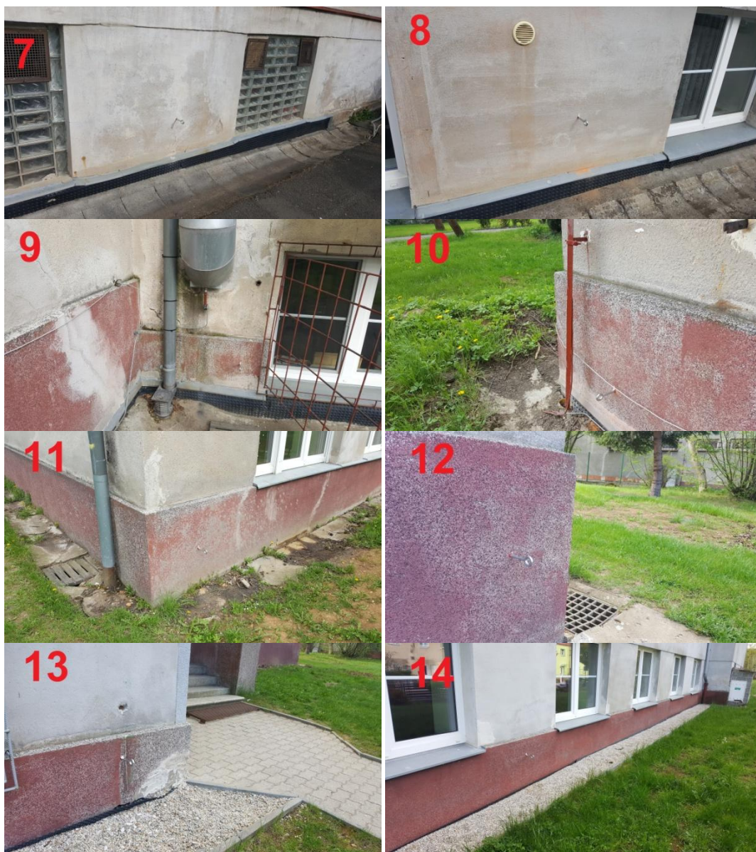
(obr. 16 Stabilizace bodů 7 až14)
