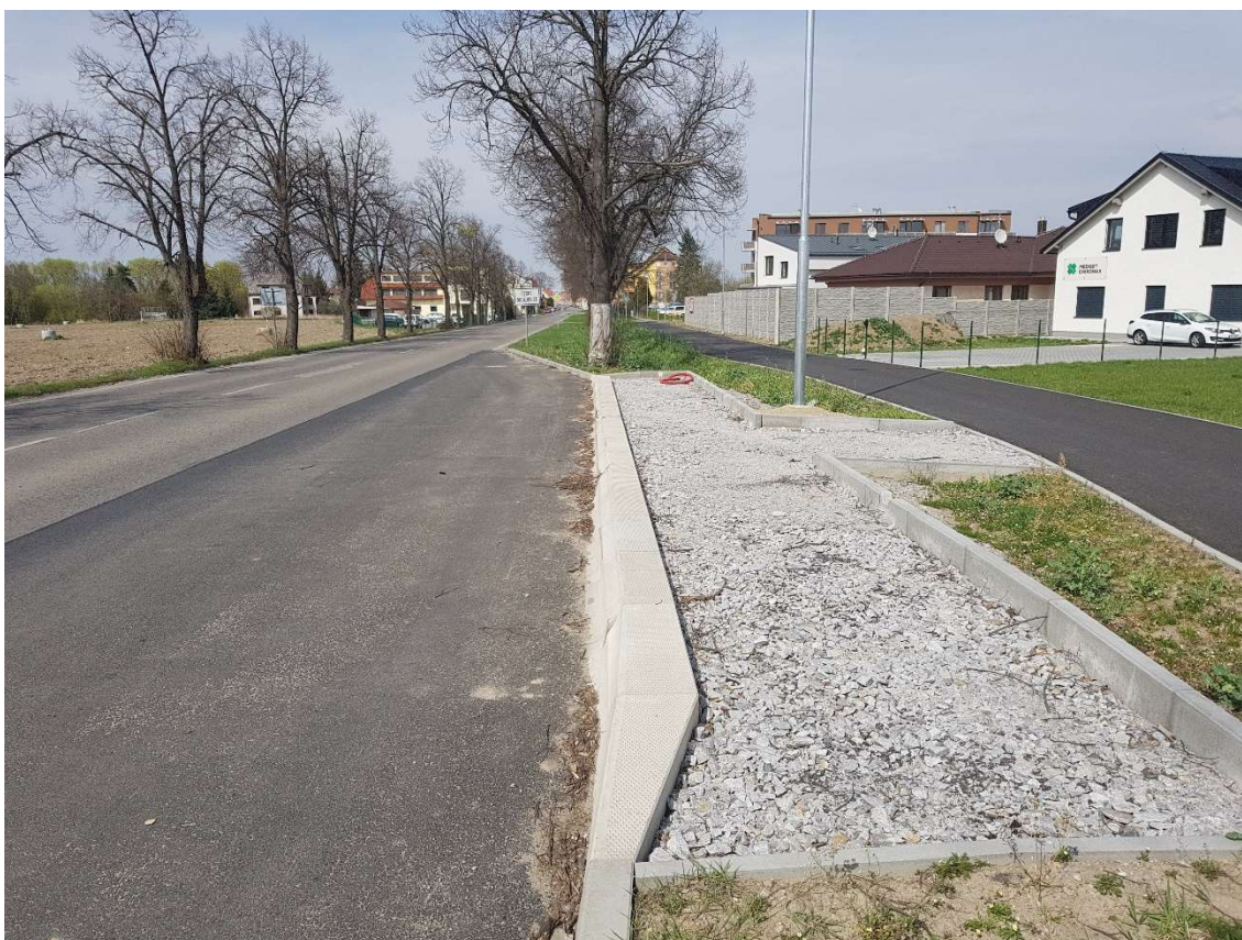
Obrázek 4 Zastávka MHD ve výstavbě
