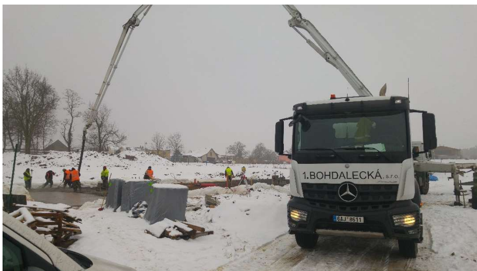
Obr. 46 Betonáž podlah na stavbě ve Vysokém Újezdu
