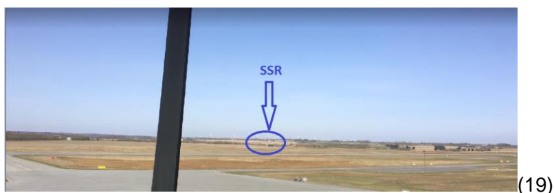
Obrázek 10 – Sekundární přehledový radar na letišti Esbjerg
