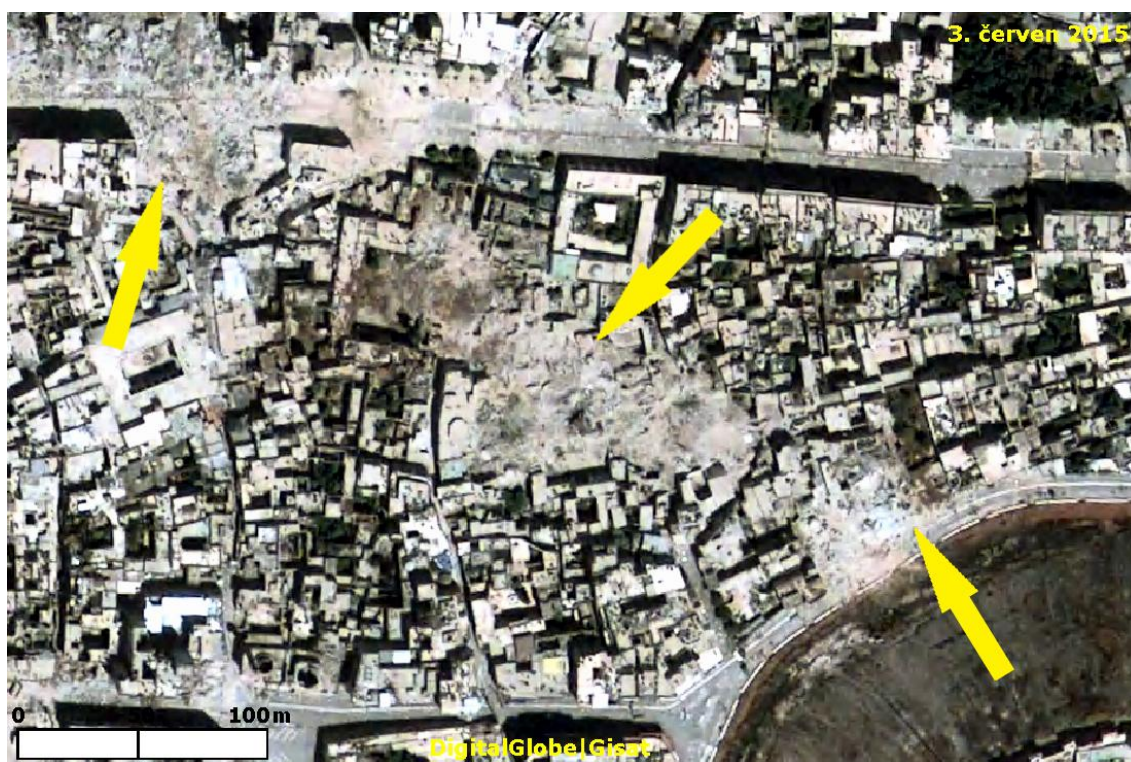
Obr. 30 Další zničené obytné budovy (žluté šipky).
