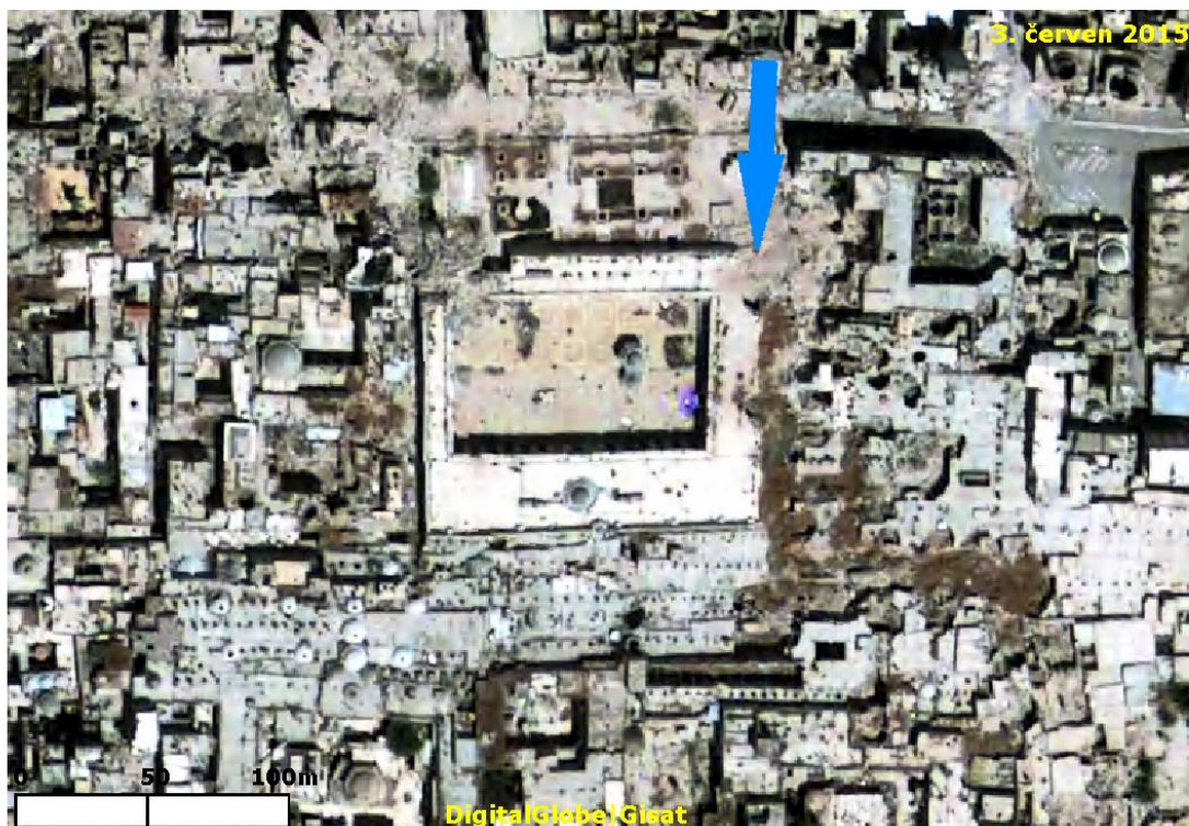
Obr. 23 Zničený severovýchodní roh mešity společně s okolními stavbami (modrá šipka).
