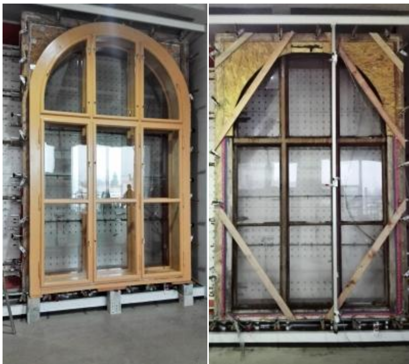
Obrázek 11 - Úprava původního okna,
