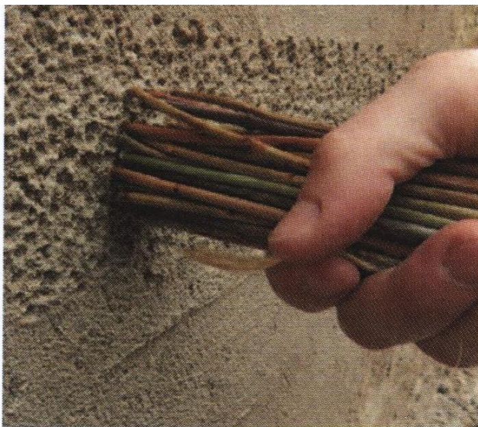
Obrázek 8 - Vpichovaná omítková bosáž-detail provádění, Zdroj: Girsá, Václav a Michoínová, Dagmar. Tradiční vápenné omítky. Poznání a praktické postupy. Praha : Informační centrum ČKAIT, 2015. ISBN: 978-80-87438-72-5
