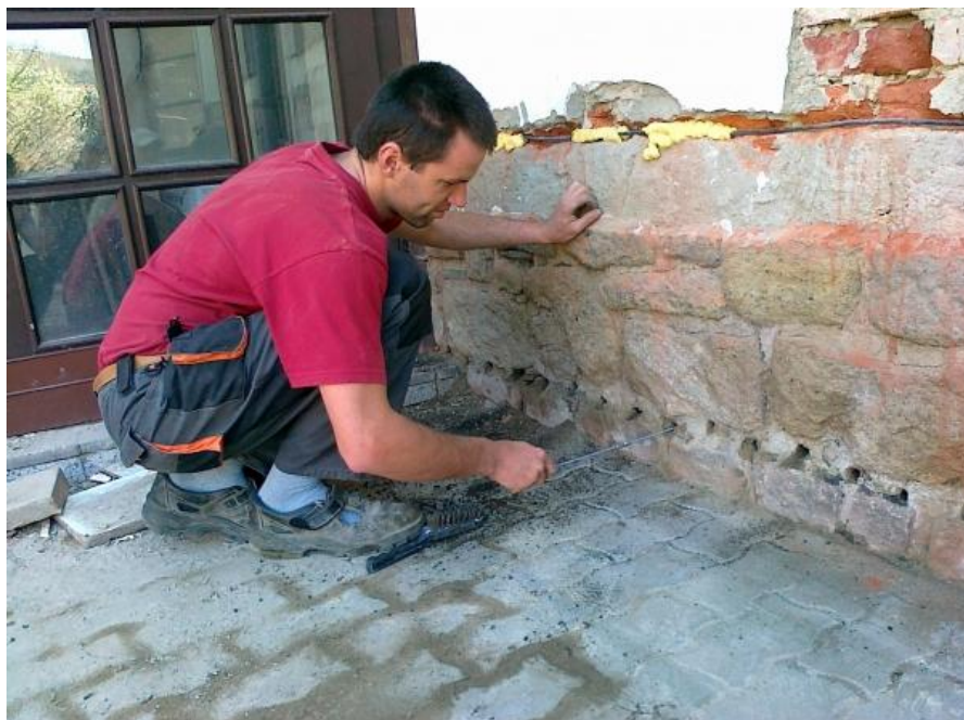
Obrázek 1 - Injektáž zdiva, Zdroj: http://www.stanion.cz/bystrice/projekcni-kancelar/injektaz-zdiva/ (online: 24.5.2018)
