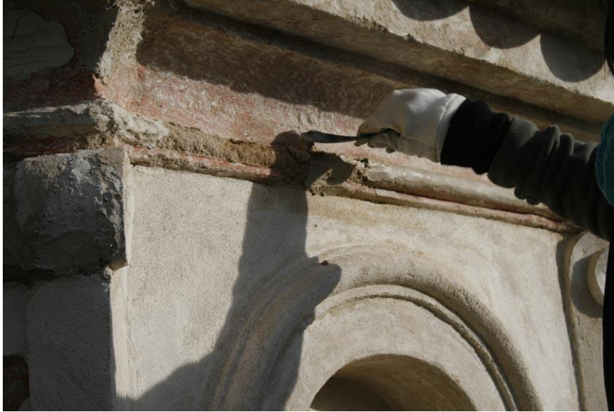
Obrázek 7 - Reprofilace štukové výzdoby, Zdroj: Skalíková, Kateřina . Obnova památek-Boží muka Úvalno . Za Opavu. 2010
