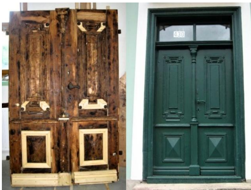
Obrázek 12 - Rekonstrukce dveří, Zdroj: http://www.truhlarime.cz/galerie/z-vyroby.html (online: 24.5.2018)
