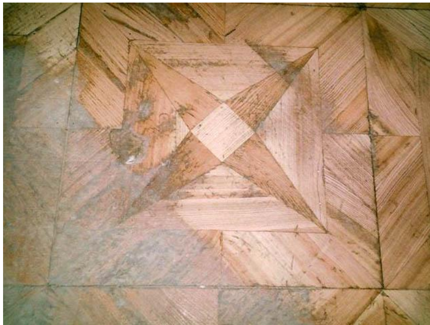
Obrázek 17 - Renovace dřevěné podlahy, Zdroj: http://www.truhlarime.cz/galerie/z-vyroby.html (online: 24.5.2018)
