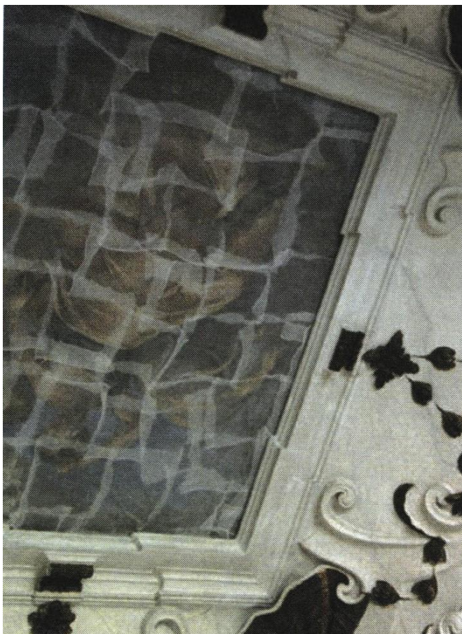
Obrázek 6 - Zajištěná omítka s nástrojnou malbou při opravě dřevěné konstrukce stropu zámek Veltrusy, Zdroj: 7. Gírsa, Václav a Michoínová, Dagmar. Tradiční vápenné omítky. Poznání a praktické postupy. Praha : Informační centrum ČKAIT, 2015. ISBN: 978-80-87438-72
