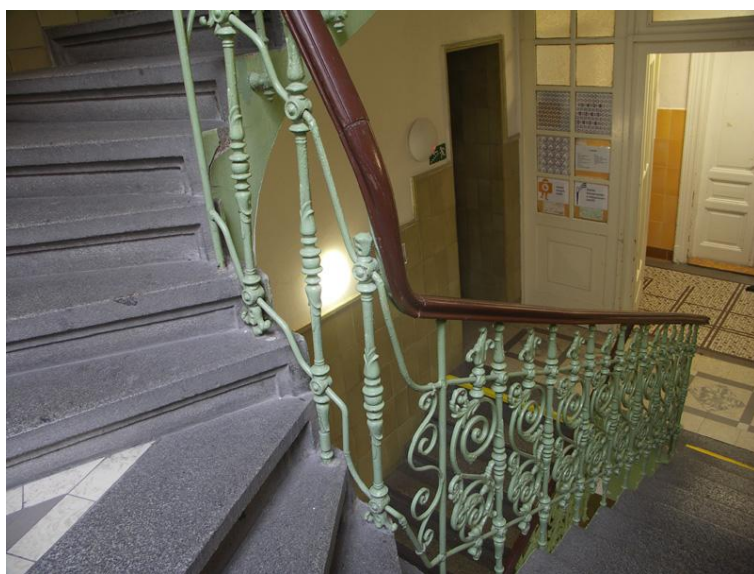
Obrázek 14 - Původní stav zábradlí, Zdroj: http://www.reno-tech.cz/fotogalerie/ze-starehono-ve/historicke-budovy-pamatky/renovace-zabradli-vos-praha/ (online: 24.5.2018)
