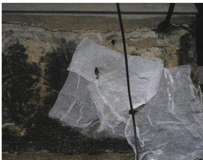
Obrázek 5 - Přelepy omítek při restaurování hrad Grabštejn, Zdroj: 7. Girsá, Václav a Michoínová, Dagmar. Tradiční vápenné omítky. Poznání a praktické postupy. Praha : Informační centrum ČKAIT, 2015. ISBN: 978-80-87438-72
