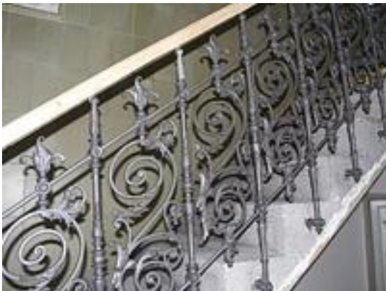
Obrázek 16 - Finální stav zábradlí po pískování a penetraci, Zdroj: http://www.reno-tech.cz/fotogalerie/ze-stareho-nove/historicke-budovy-pamatky/renovace-zabradli-vos-praha/ (online:24.5.2018)
