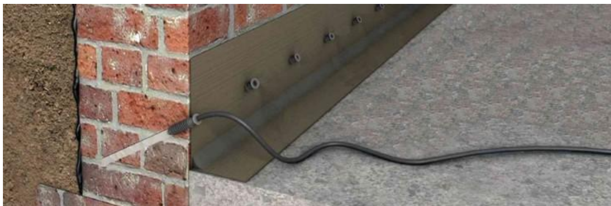
Obrázek 2 - Injektování zdiva, Zdroj: http://www.rssg.cz/provadeni-sanacnich-praci/injektaz-proti-vzlinajici-vlhkosti (online: 24.5.2018)
