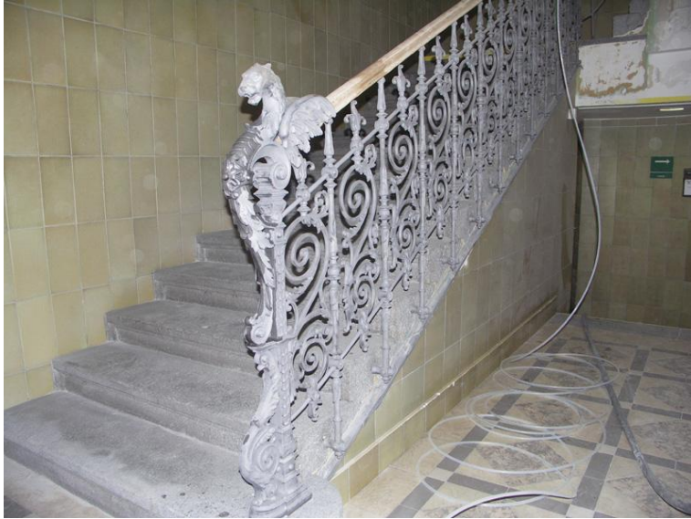
Obrázek 15 - Pískování zábradlí, Zdroj: http://www.reno-tech.cz/fotogalerie/ze-stareho-nove/historicke-budovy-pamatky/renovace-zabradli-vos-praha/ (online: 24.5.2018)
