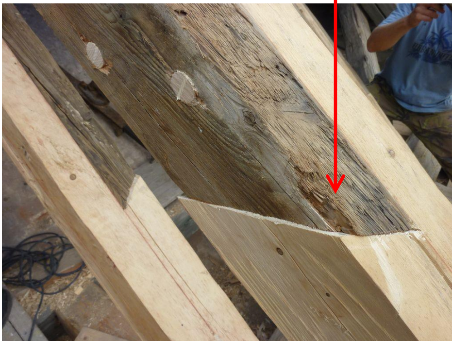
Obrázek 4 - Sanace krovu, Zdroj: http://www.chatar-chalupar.cz/oprava-krovu-2/ (online: 24.5.2018)
