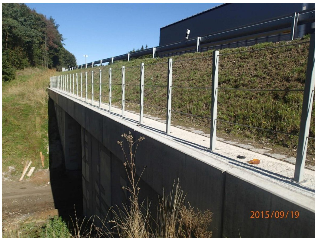
Obr. 1 Zábradlí na přesypaném mostě na D1
