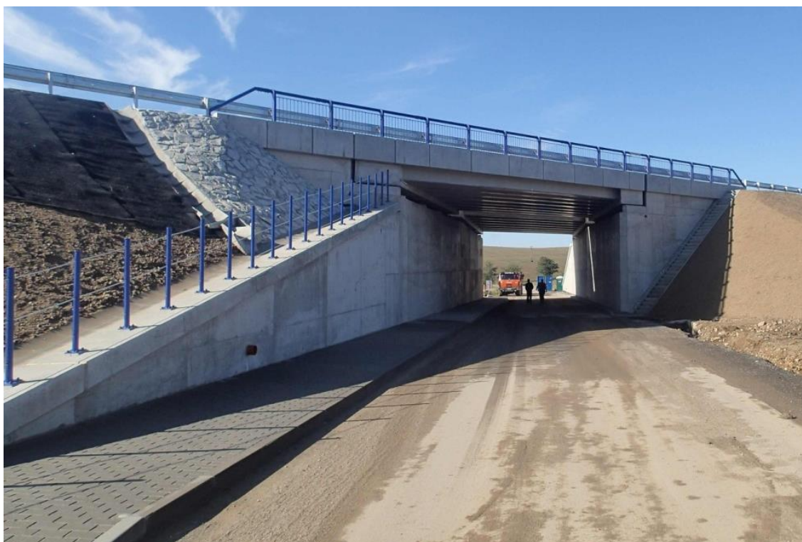
Obr. 2 Zábradlí na křídle mostu na D1
