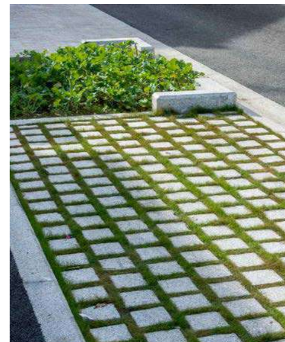
DLAŽBA UMOŽŇUJÍCÍ PRORŮSTÁNÍ TRÁVY, DLAŽEBNÍ KOSTKY STEJNÉHO FORMÁTU JAKO NA CHODNÍCÍCH
