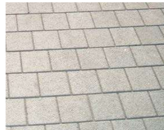
DLÁŽDĚNÍ CHODNÍKŮ A PĚŠÍ TŘÍDY (UMOŽŇUJÍCÍ ZASAKOVÁNÍ VODY)
