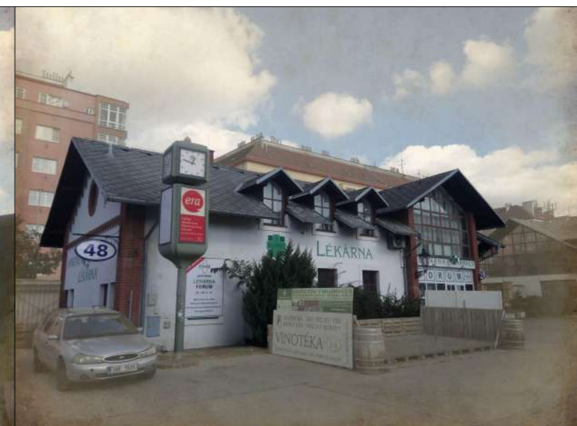
Č. 48 : Současný objekt určený k demolici.
