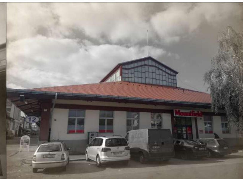
Č. 12 : III. etapa (1920 - 1945) Navrženo odstranění 1/4 přízemí objektu směrem k veřejného prostranství kultury se zachováním střešní konstrukce. Využití pro pivnici, možná redukce zadní části pro obchod.
