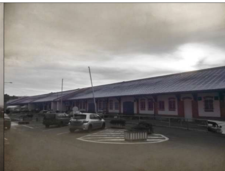
Č. 7-9 : I. etapa (do roku 1920) Nová pasáž spojující objekty č. 7, 8, 9, 11, 12. Ve střední hale vznik podkroví s podélnými vikýři pro vznik bytů a ateliérů. Nižší haly budou sloužit pro obchod. U objektů 7, 8, 9 vznik tří pasáží v 1.NP.
