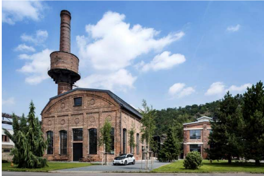
Rekonstrukce kotelny v Libčicích, Česká republika
