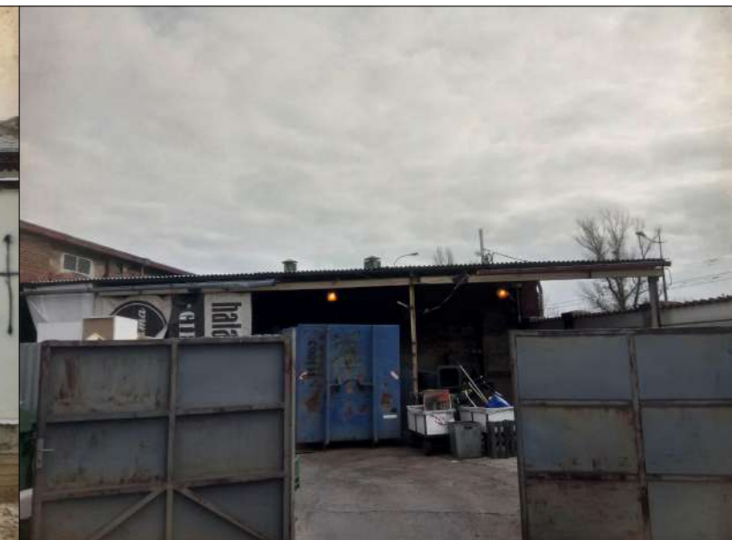
Přístavba za objektem č. 26 určená k odstranění.
