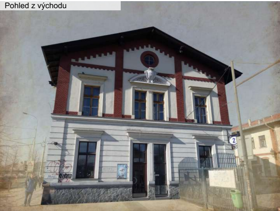
Pohled z východu
