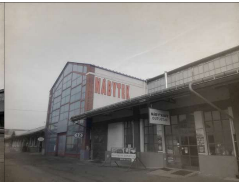
Č. X1 : III. etapa (1920 - 1945) Vysoká hala mezi objekty 11 a 12. Vznik nové vnitřní nosné konstrukce pro vybudování tří nových podlaží s funkčním využitím obchodu.
