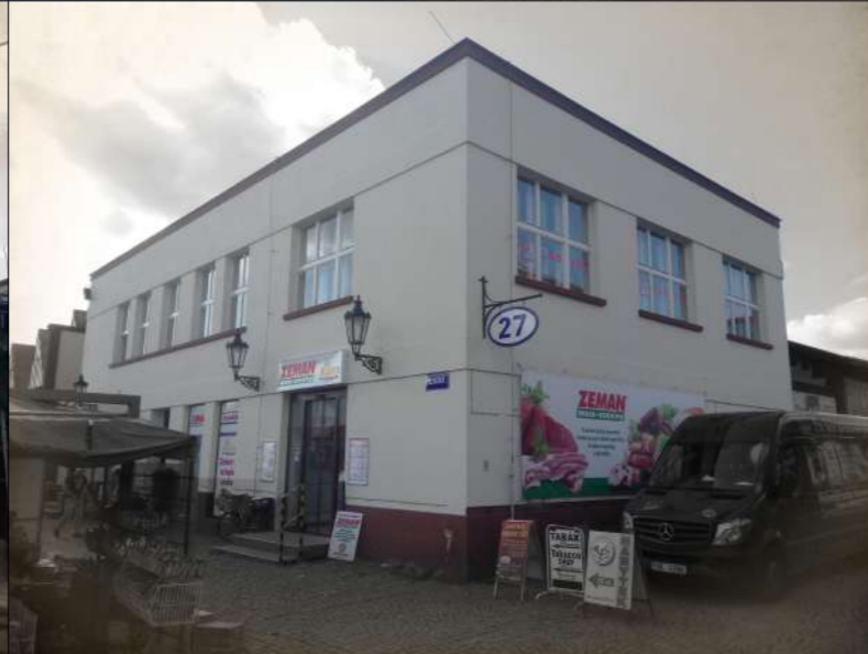
Č. 27 : Pozdní dostavba, mimo arch. podobu okolní zástavby. Navržena valbová a sedlová střecha pro vznik podkroví. Objekt bude využit jako pocilejná stanice.
