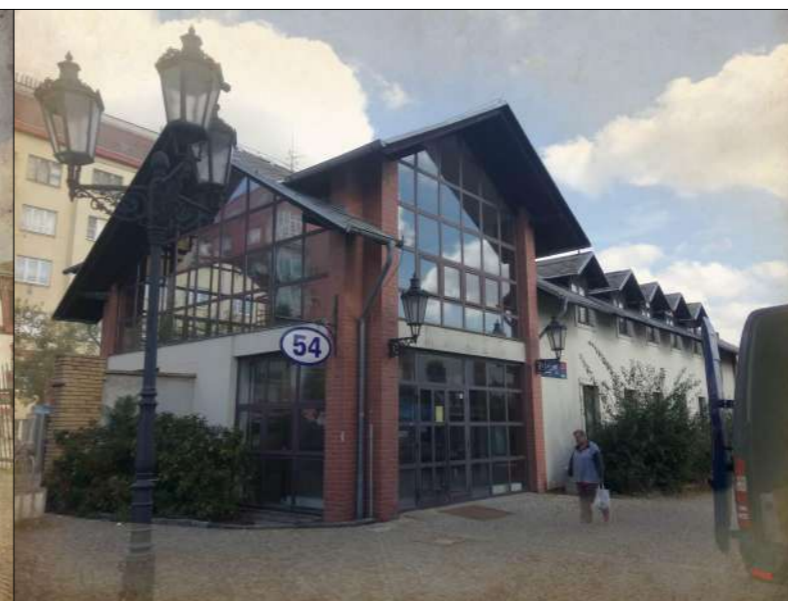
Č. 54 : Současný objekt určený k demolici.
