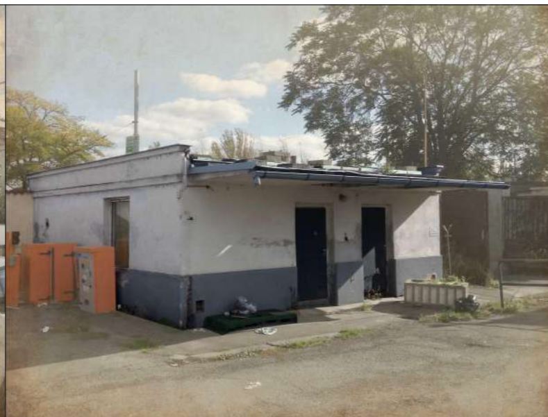
Drobná stavba na východě areálu, která bude stržena.
