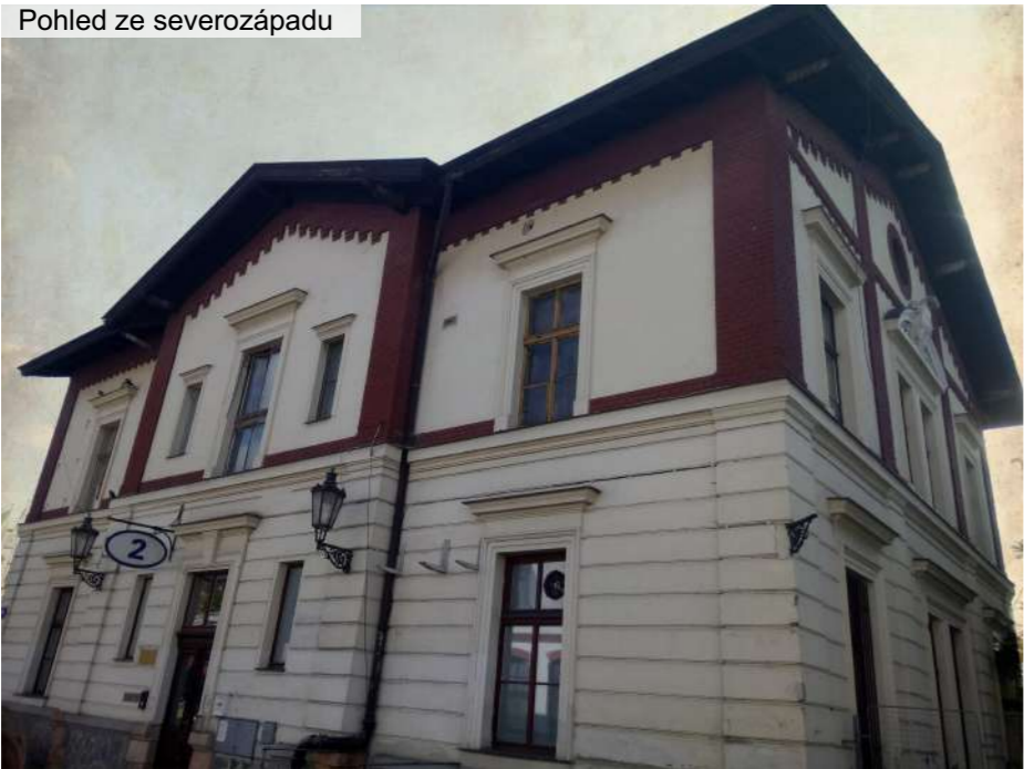
Pohled ze severozápadu
