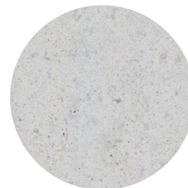
P11 schodiště, fontána strukturovaný pohledový beton
