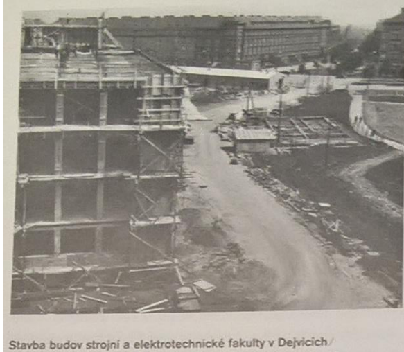
Stavba budov strojní a elektrotechnické fakulty v Dejvicích/ Obrázek 3 Stavba budov strojní a elektrotechnické fakulty v Dejvicích
