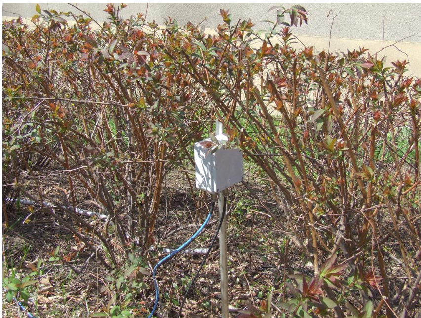
Obrázek 3.1 Auto-detekční senzor instalovaný před parkovacím místem
