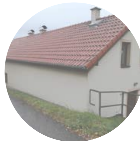
Strohost fasády, bílá omítka s minimem oken
