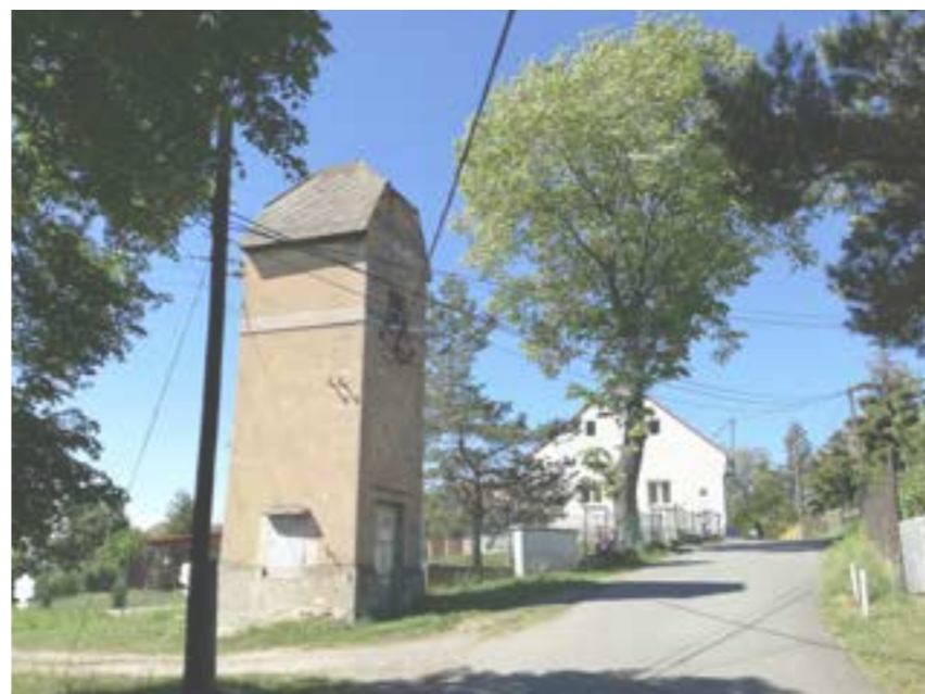
← Příchod z východu - pohled na trafo-stanici, v pozadí MŠ
