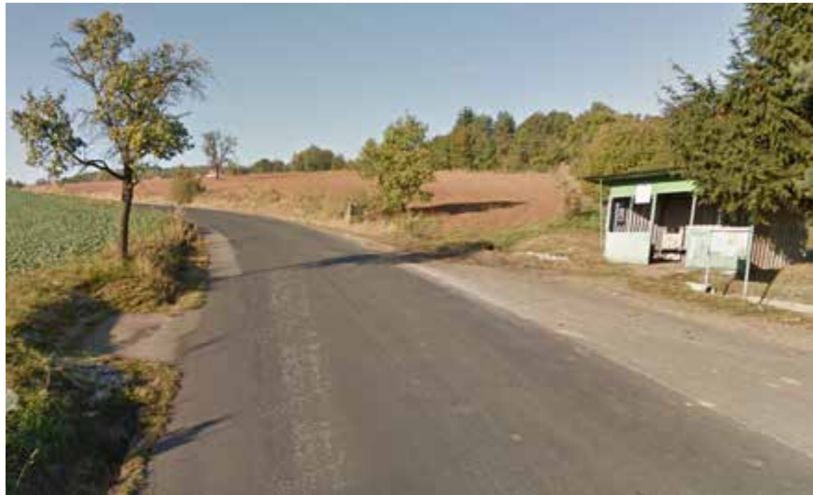
Ilustrativní snímek zachycující současný stav zastávek ve Svaté
