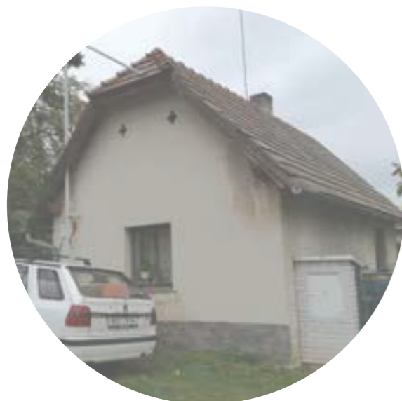
Ozdobné větrací otvory ve tvaru kříže ve štítové fasádě - typické pro stodoly - 2 kříže
