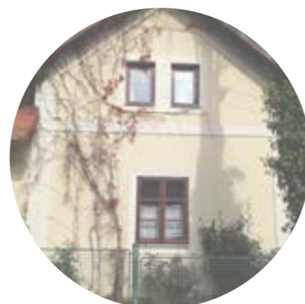
Lizénové rámce ve štítu na úrovni římsy. Někdy je kombinován s vodorovným dělením a vznikají tak lizénová pole.
