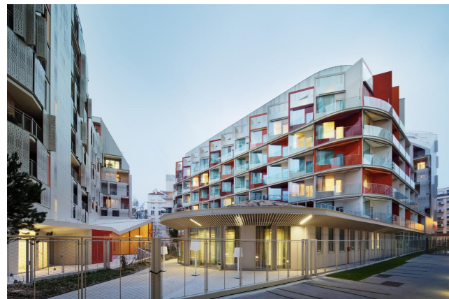
NURISING HOUSE, ATELIÉR DU PONT, PAŘÍŽ, FRANCIE, 2015
